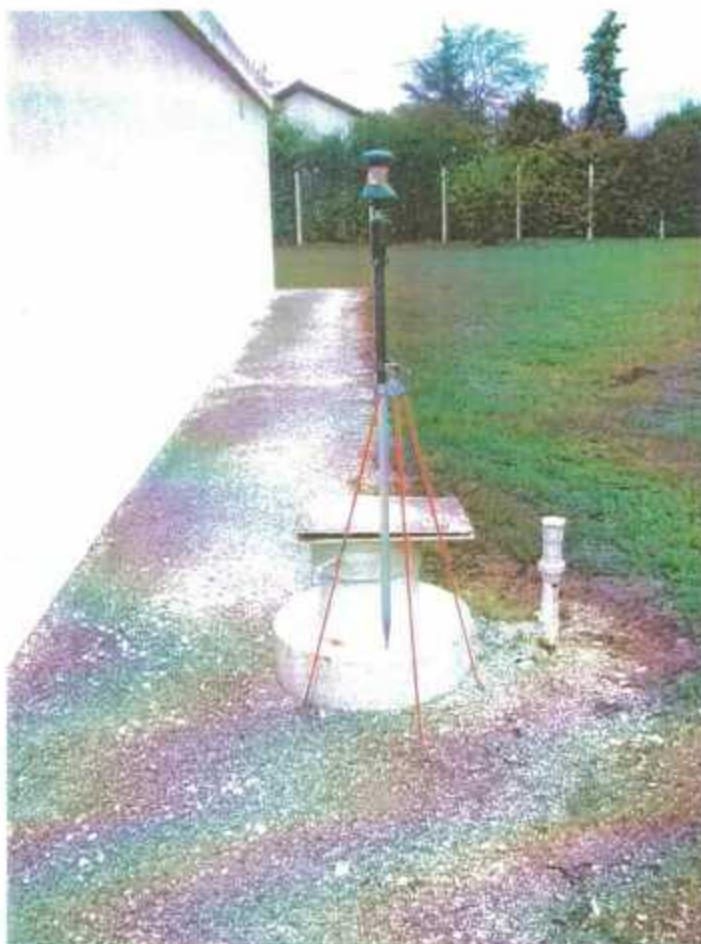
Photographie du nivellement de l'ouvrage n° 37
