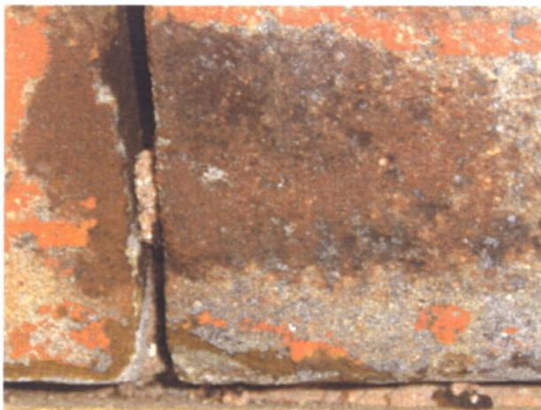
**Photo 10 - Etat des joints émergés sur la maçonnerie de 1832 du puits César
