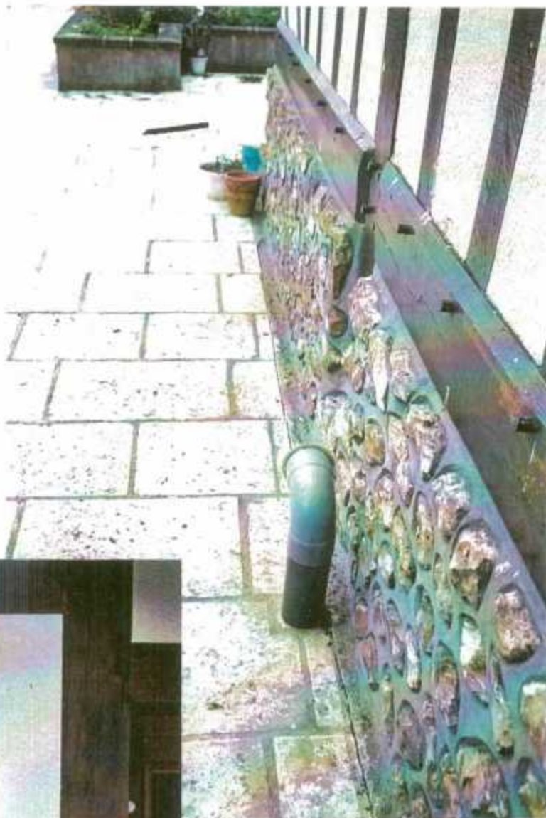
Photo 4 : Vue d'une des quelques fissures horizontales sur les enduits placés entre les colombages, façade nord de l'habitation, parcelle D545, commune de Fort-Moville (27).
