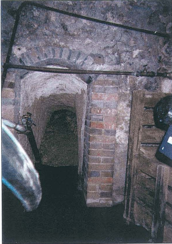
Photo 6 (ci-contre) – Galerie effondrée menant au puits de Mme LARMANDIER. Notons le niveau d'eau le 30/01/2001.
