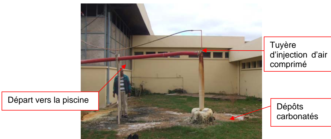
Illustration 10 - Tête du forage de la piscine ou Ranomafana VI
