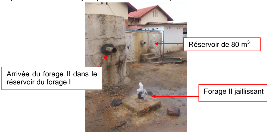
Illustration 9 - Tête du forage II ou Ranomafana V
