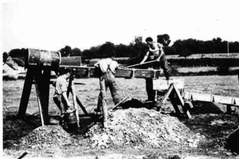
chargement des graviers dans le longtom
