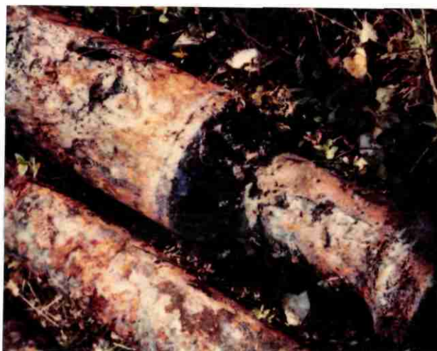
Photo Pompe Creil
