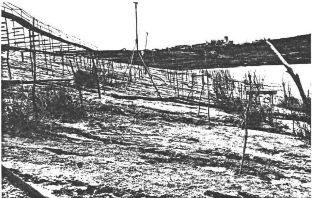
Photo 7 : Mise en végétation du talus amont de la digue actuelle. Installation d'arrosage automatique en fonction du degré d'humidité de la digue.
