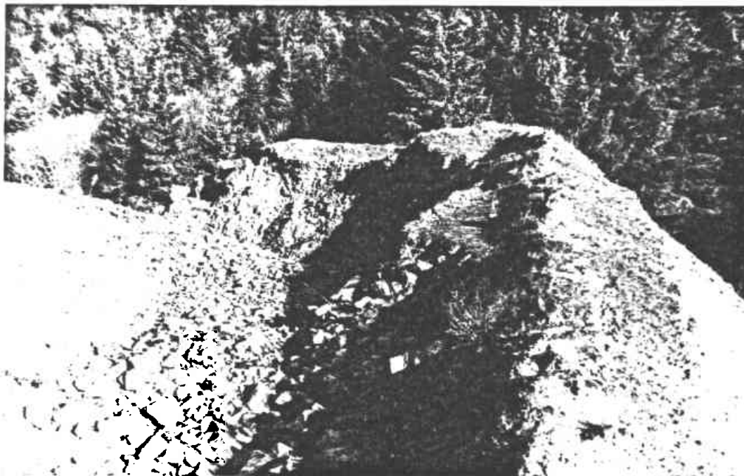
Photo 2 : Important ravinement de la digue située en amont de la mine. Comblement de la ravine par des caillasses venant des stériles de mine
