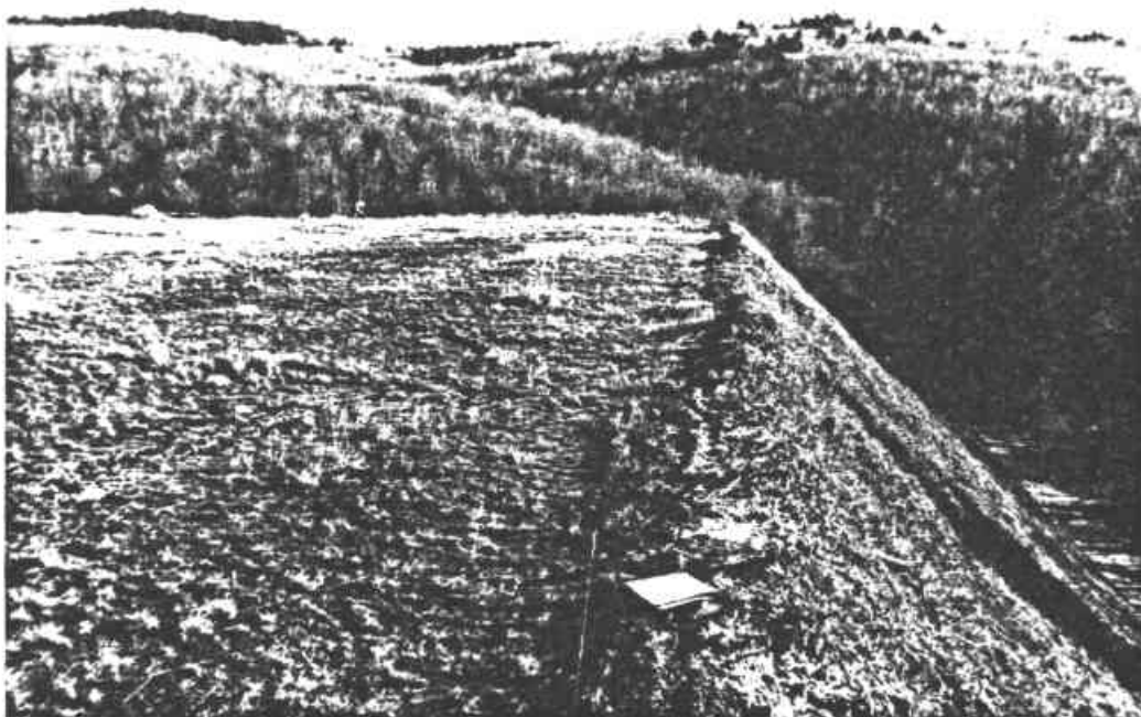
Photo 3 : Digue située à l'aval de la mine. Légère fixation du dépôt par quelques herbes et mousses.
