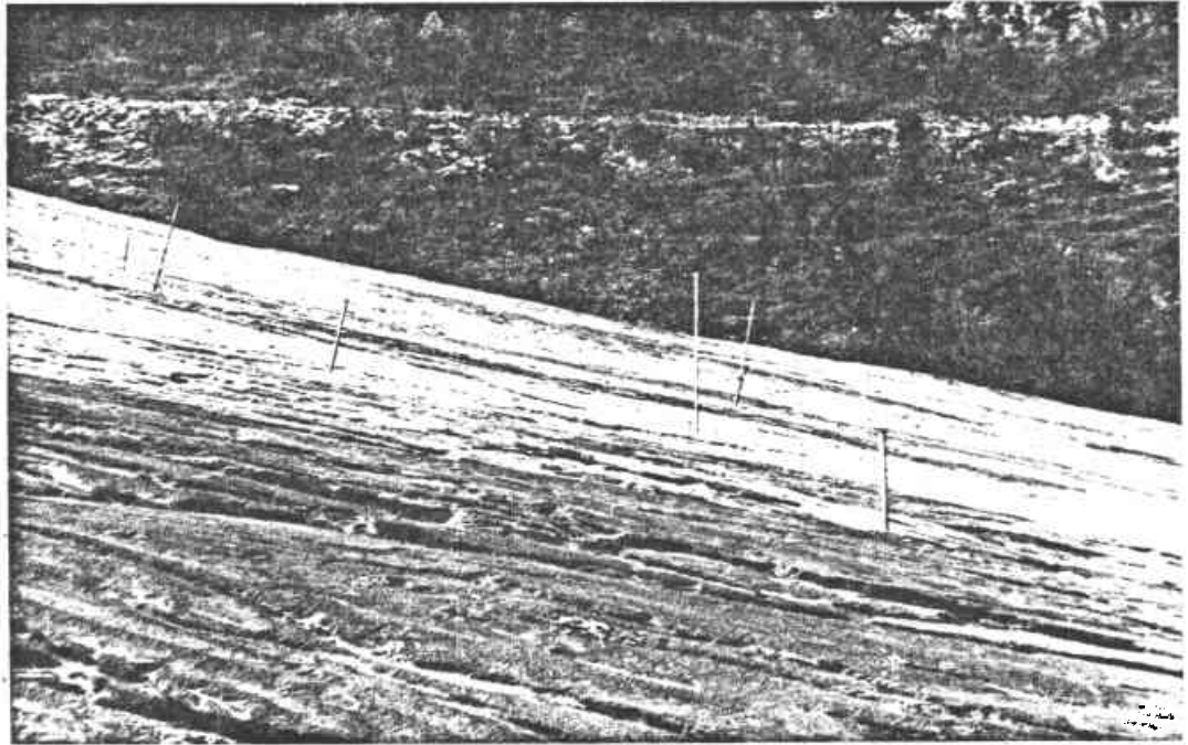
Photo 4 : Talus aval de la digue à stériles. Au premier plan, ravinement du talus de la partie (sombre) non fraîchement recouverte par les produits de sousverse.
