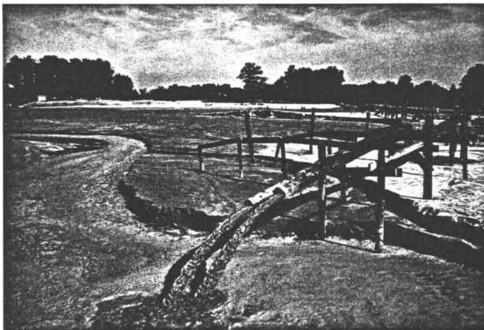
Photo 2 : Déversement des déchets de laverie dans le bassin de décantation
