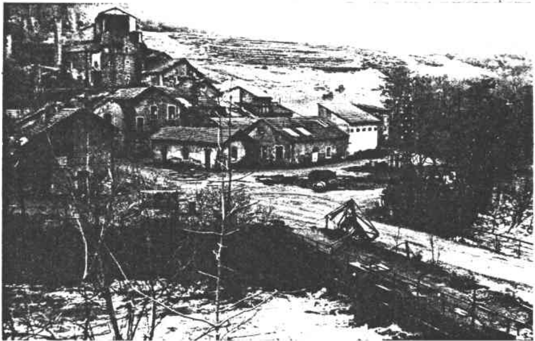
Photo 1 : Vue générale des bâtiments de l'usine de traitement et de la digue à stérile (au sud). Au premier plan, la rivière Le Dadou.
