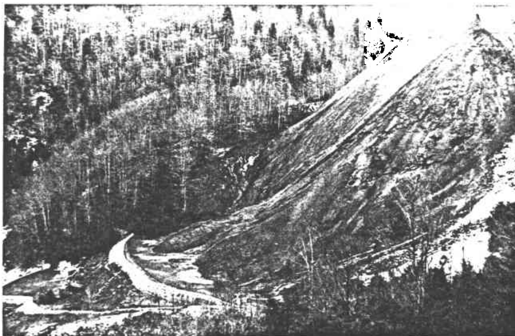
Photo 4 : Talus aval du dépôt et digues de pied
