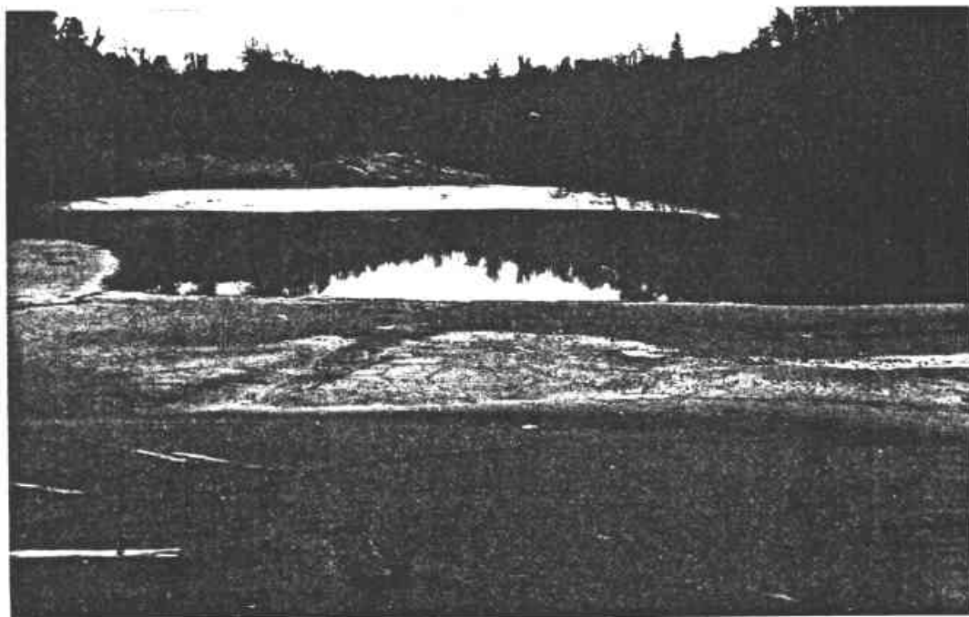
Photo 4 : Sommet de la digue secondaire (amont) le centre du bassin de décantation est occupé par un petit lac.
