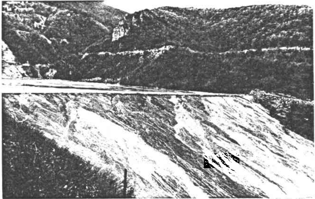
Photo 1 : Vue générale du bassin de décantation et du talus aval de la digue.
