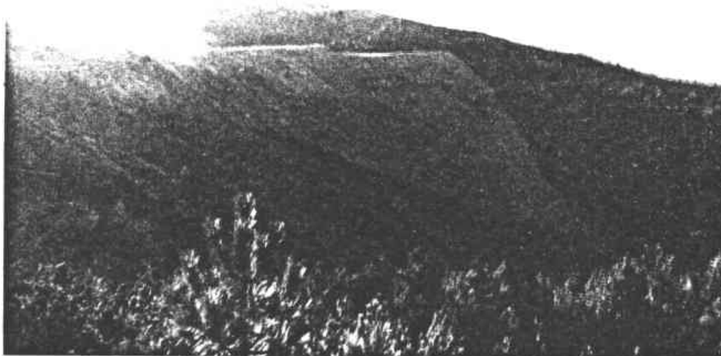
Photo 9 : Dépôt de stériles de la carrière d'Escaro : talus aval barrant le ravin de la Canalette.
