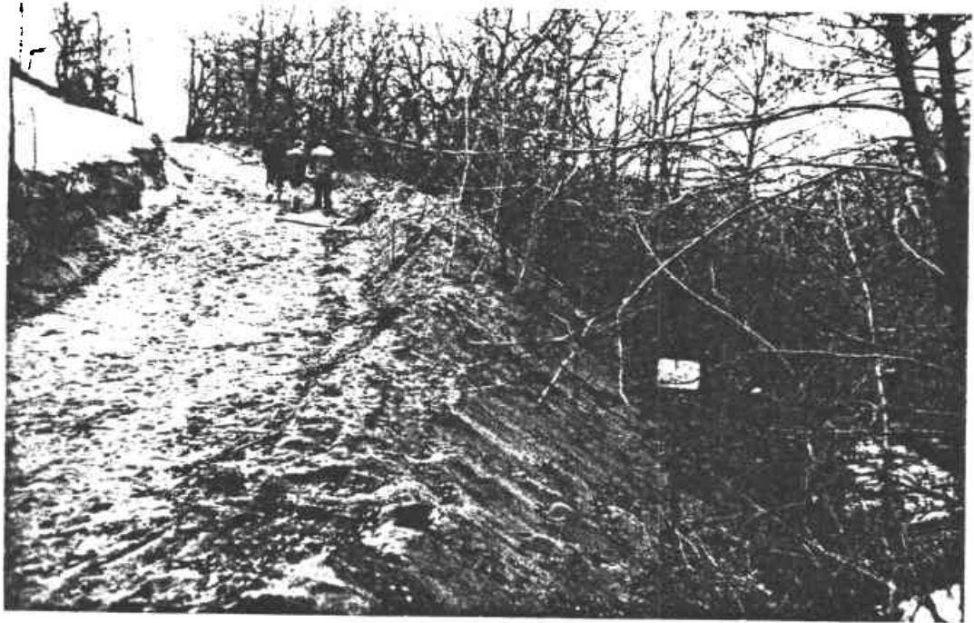
Photo 6 : Sentier tracé au pied de la digue principale (pratiquement sur le terrain naturel) à partir duquel il est prévu de construire un enrochement protégeant le mur de la digue.
