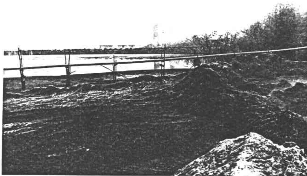
Photo 2 : Sousverse (partie droite de la photo) provenant du cyclonage des stériles de laverie et destinée à la construction de la digue transversale (à l'arrière-plan). Tuyauterie de la surverse.
