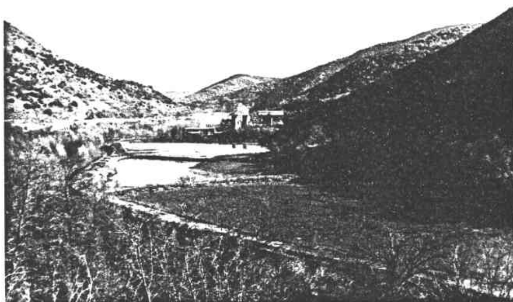
Photo 1 : Vue générale des bassins de décantation de stériles de laverie de La Bastide
