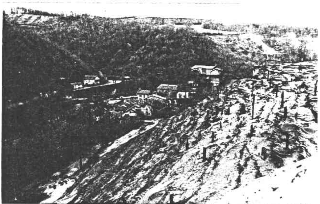
Photo 3 : Talus de la digue principale construite selon le principe de la méthode amont. En bas de la digue, le sentier qui supportera le mur en enrochement.(cf paragraphe d)
