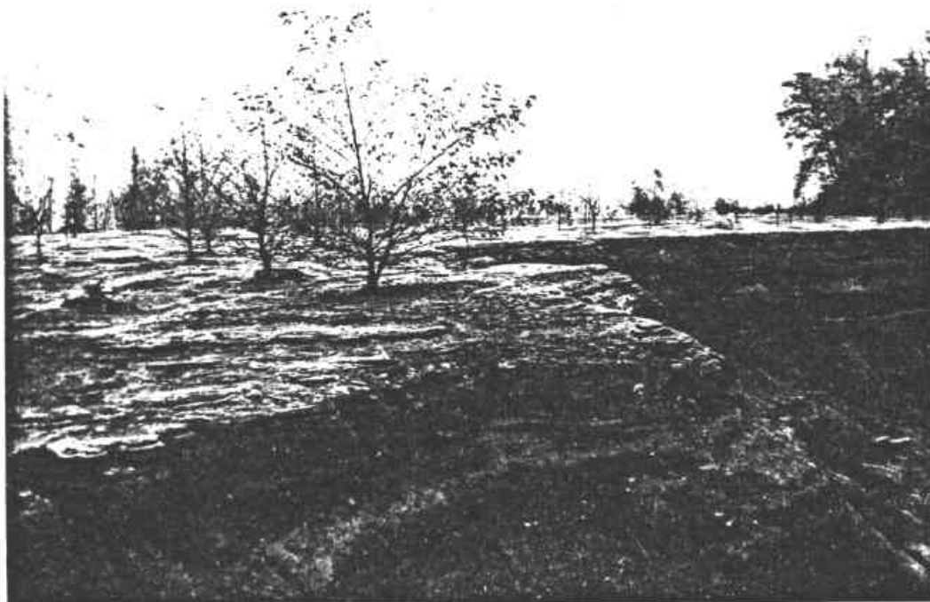
Photo 6 : Bassin de décantation n° 6 (achevé). Début de curage (abandonné). Plantation. Traces d'érosion éolienne.
