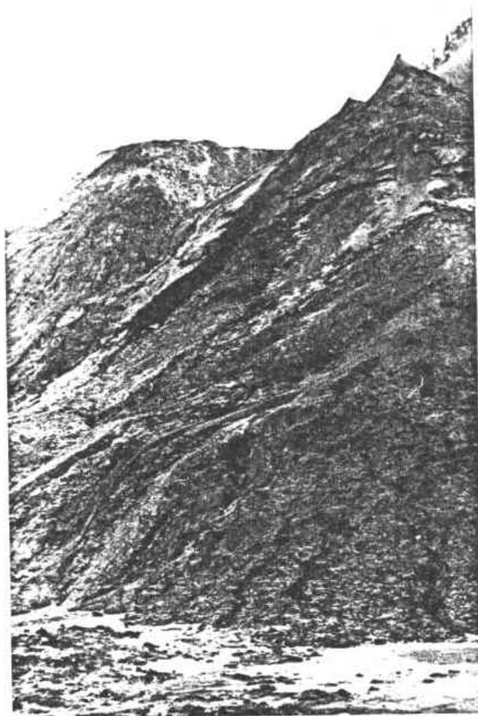
Photo 9 : Glissements de plaques sur le talus aval du dépôt et ravinements (dûs à l'écoulement des eaux de pluies lors des précipitations orageuses)
