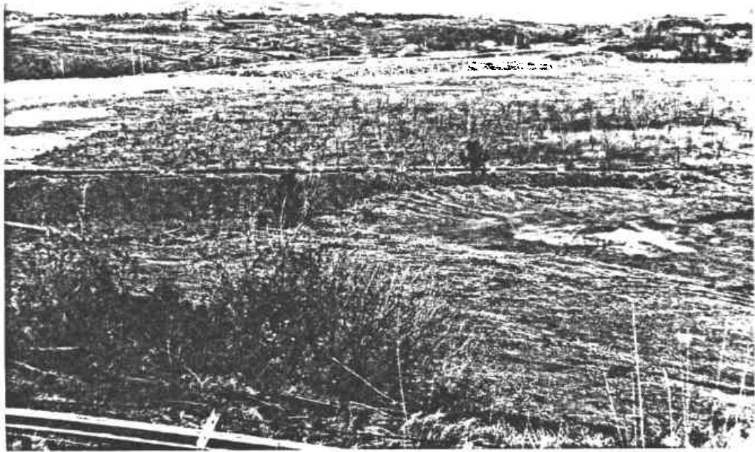
Photo 8 : Mise en végétation de la digue expérimentale. Au premier plan, goulotte amenant par gravité la pulpe des stériles vers la digue aval.
