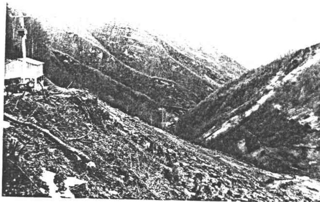
Photo 7 : Emplacement futur du nouveau dépôt de stériles de laverie au lieu-dit le "Plats des Pommiers".
