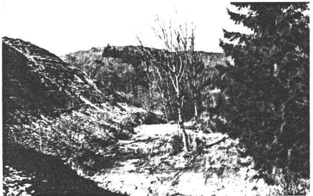
Photo 1 : Dépôt de stériles de laverie (digue située à l'amont de la mine). Talus de la digue. Plusieurs arbres morts en pied de digue.
