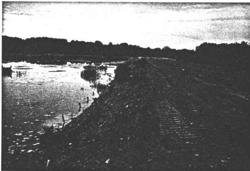
Photo 5 : vue du parement amont de la digue A (aval)
