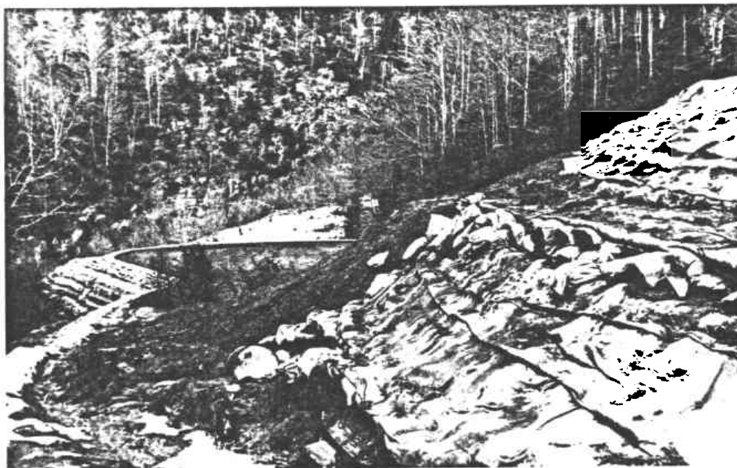
Photo 5 : Dignes de pied de talus (sacs de steriles disposés en lits successifs avec intercalation de couches de bidim).
