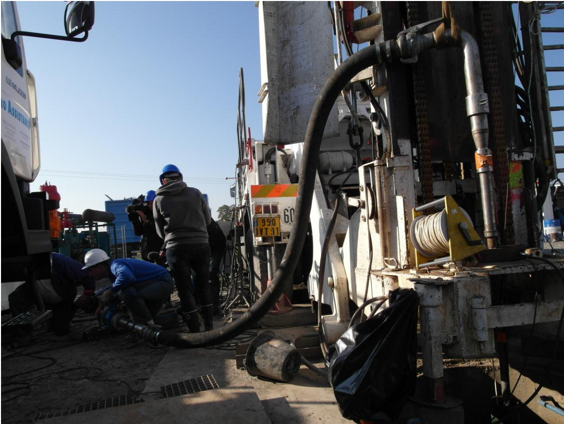
Figure 21 : Le pompage d'essai opéré par Hydro Assistance Ingénierie a été largement couvert par les médias.
