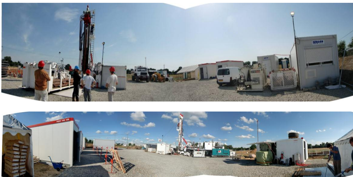
Figure 12 : Vues panoramiques sur le chantier.
