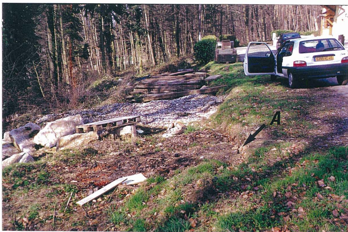
Photo 17 : Fulleren - Point N° 2b Effondrement côté sud de la rue de Ballersdoff – A = Rejet vertical de 1999
