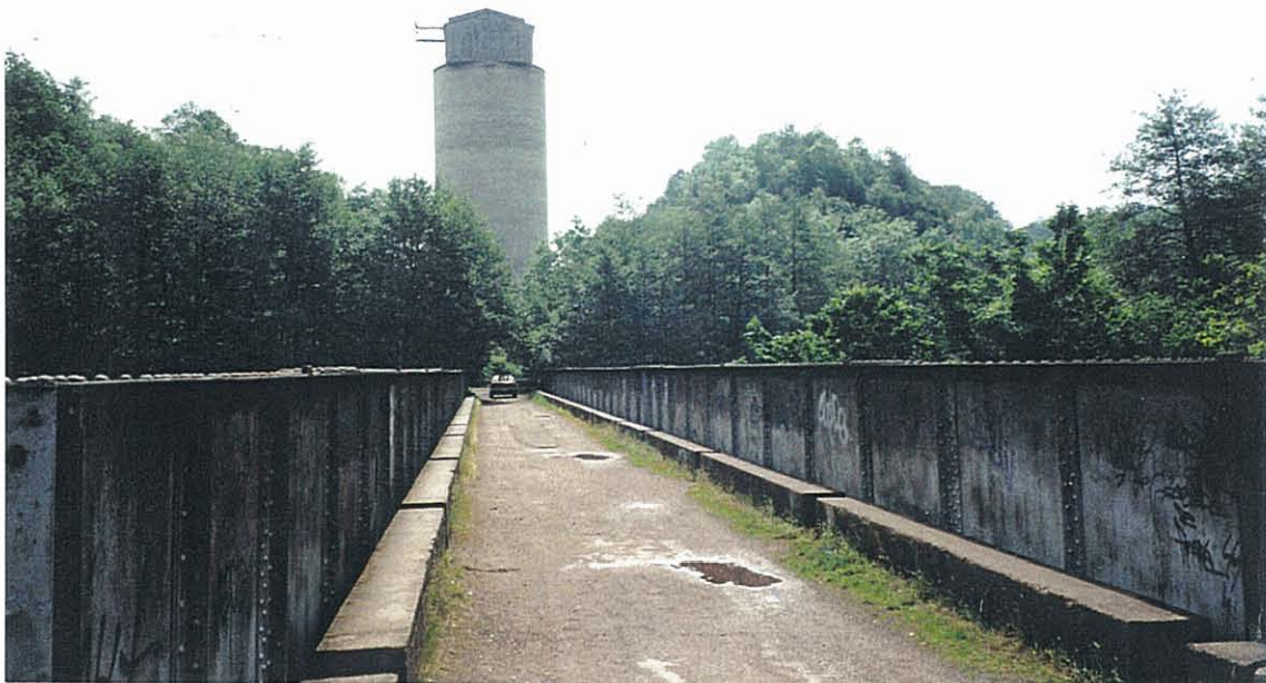
Phot. 11 – Pont métallique sur l'Orne et silo du bas.
