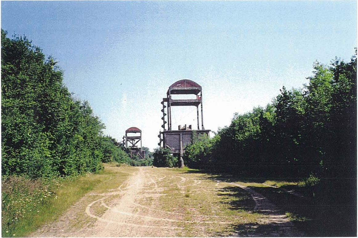
Phot. 1 – Vue d'ensemble des anciens concasseurs.
