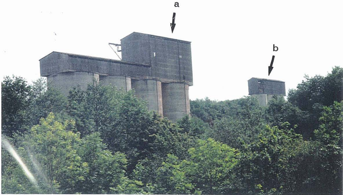
Phot. 10 – a : silo du bas b : silo du haut.
