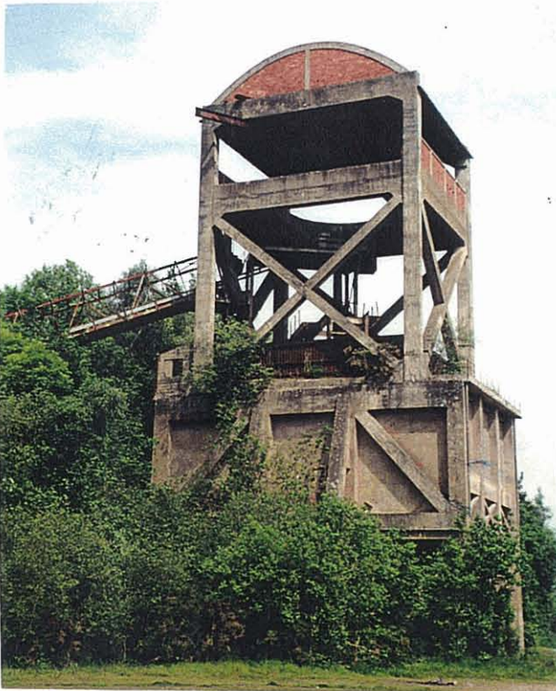
Phot. 2 – Concasseur nord. La rampe de convoyeur à bande a servi dans un 2 ème temps à amener de la pierre des carrières.
