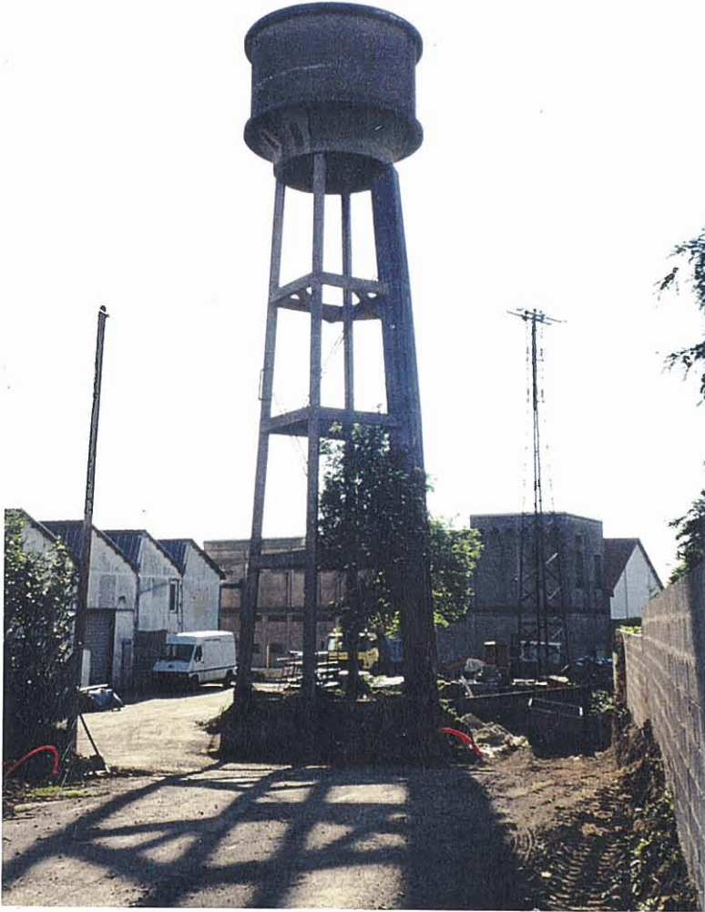
Phot. 12 – Château d'eau.
