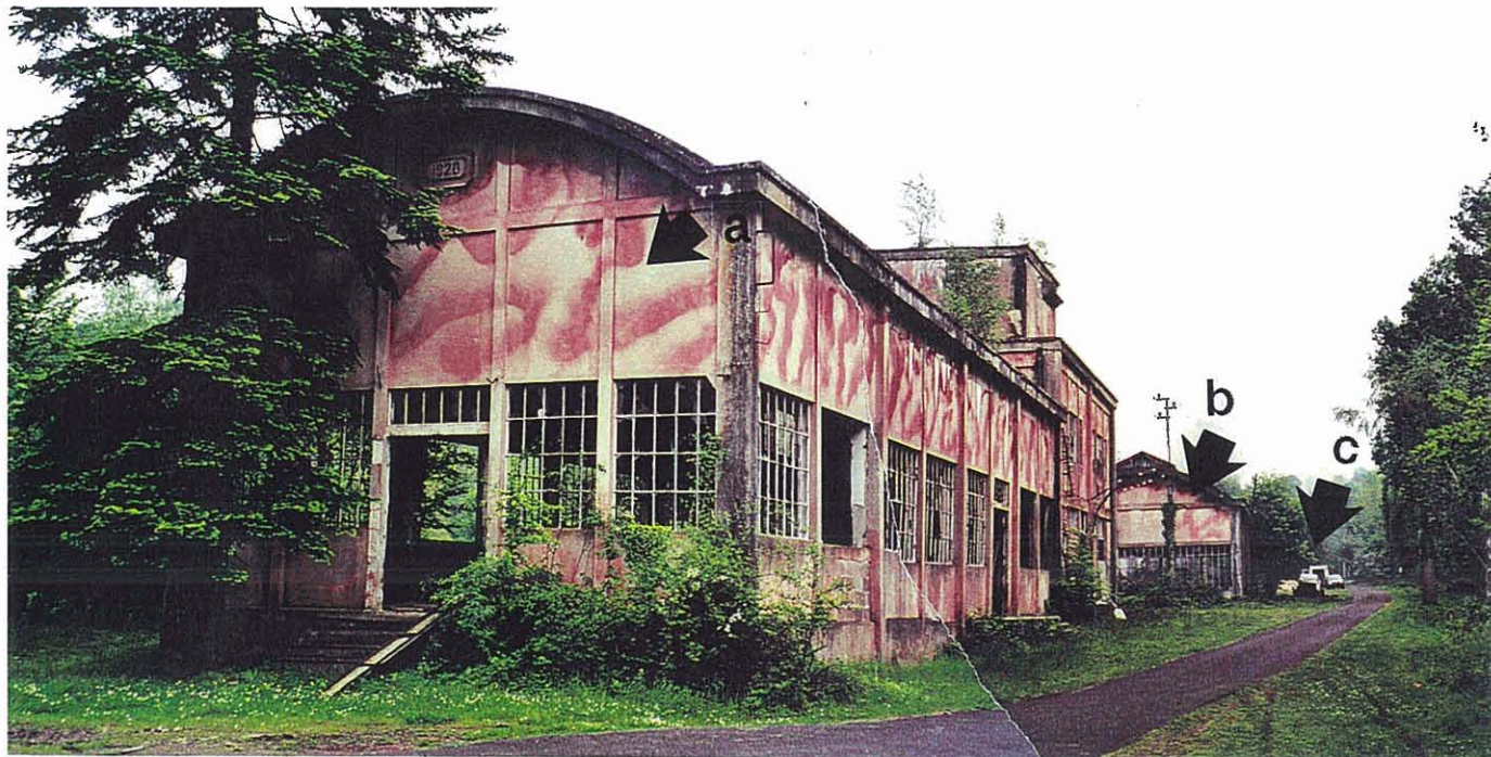
Photo 1 - a) Ancien bâtiment des compresseurs b) Ancien bâtiment des ateliers c) Ancien bâtiment des magasins non visible.
