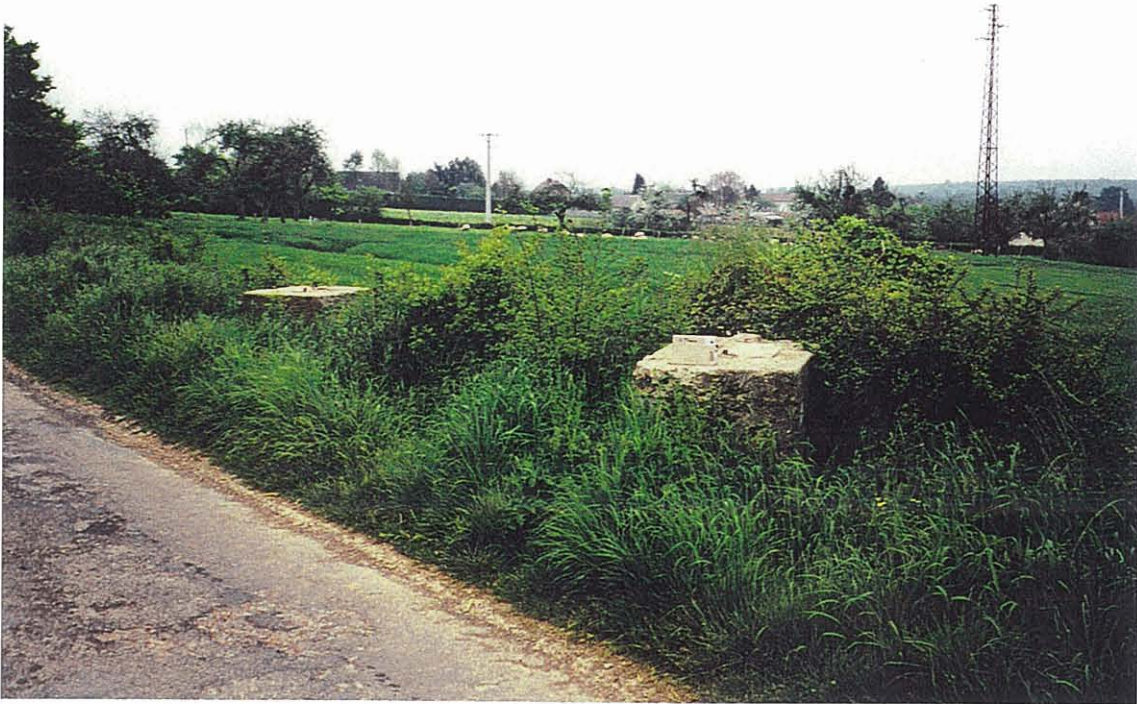
Photo 12 - Plots en béton des pylônes du transporteur aérien.
