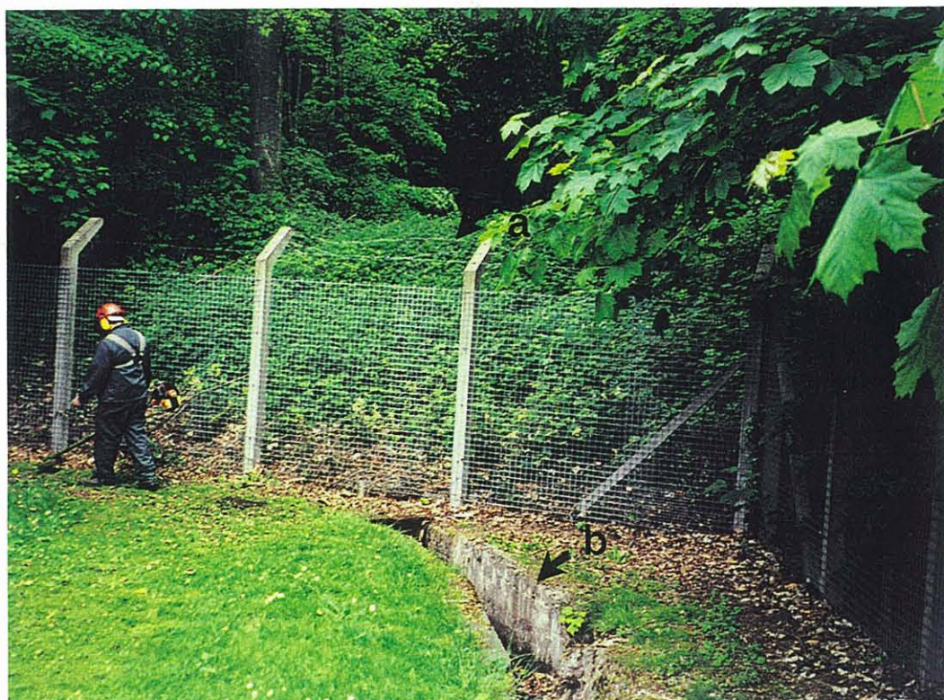
Photo 4 - Entrée mine de Gouvix a) talus marquant l'entrée b) caniveau d'exhaure à sec, les eaux étant récupérées dans une bâche de 40 m 3 qui se situe sous le gazon en dehors de la photo.
