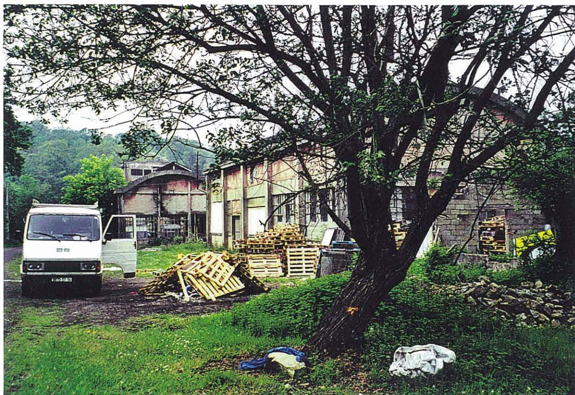
Photo 2 - Ancien bâtiment des magasins (vue du Sud).
