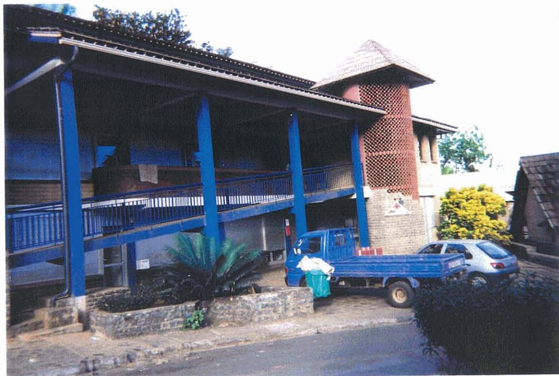
**Photo 14 : Siège de la SIM à Mamoudzou associant des moellons de basalte (rez-de-chaussée), des BTC (visibles à l'étage, à gauche de l'escalier) et des claustras en terre cuite (fabriquées à Tsimkoura)**
