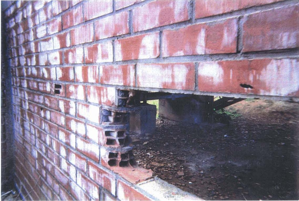
**Photo 22 : Détail de la construction de la briqueterie de Tsimkoura, mettant en évidence une trop grande largeur des joints**
