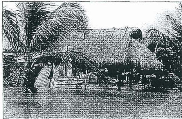
Les carbeta de travail ont été inondés par une quarantaine de centimètres d'eau.
