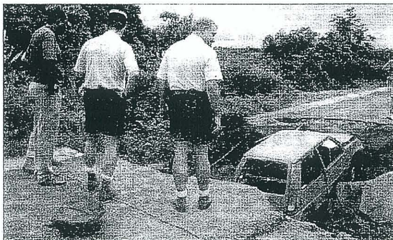
La voiture s'est encastrée au niveau de l'effondrement de la route.
