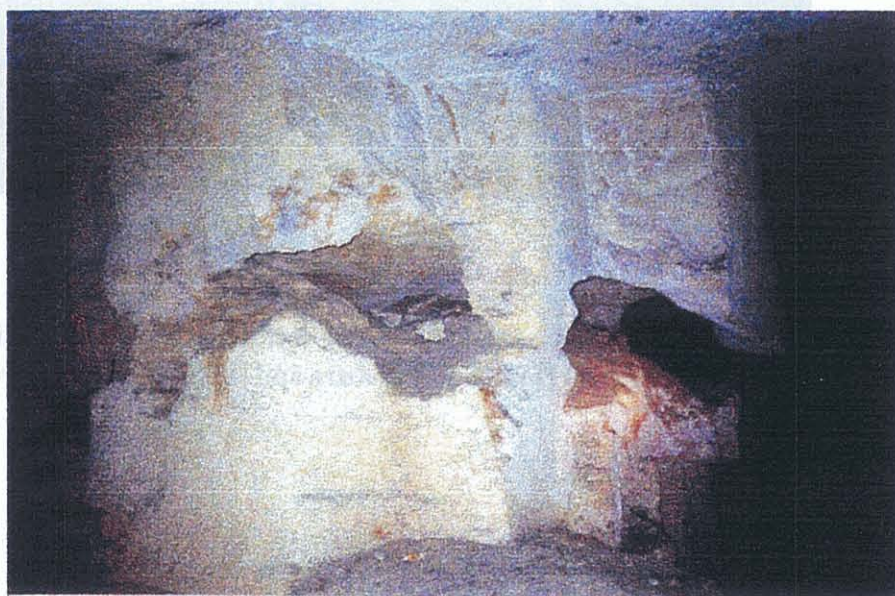
Figure 8 - Poche karstique stratiforme laissée en place dans un pilier, au niveau supérieur du chai de Château-Belair (niveau supérieur, au sud-ouest de la cavité 2.2)
