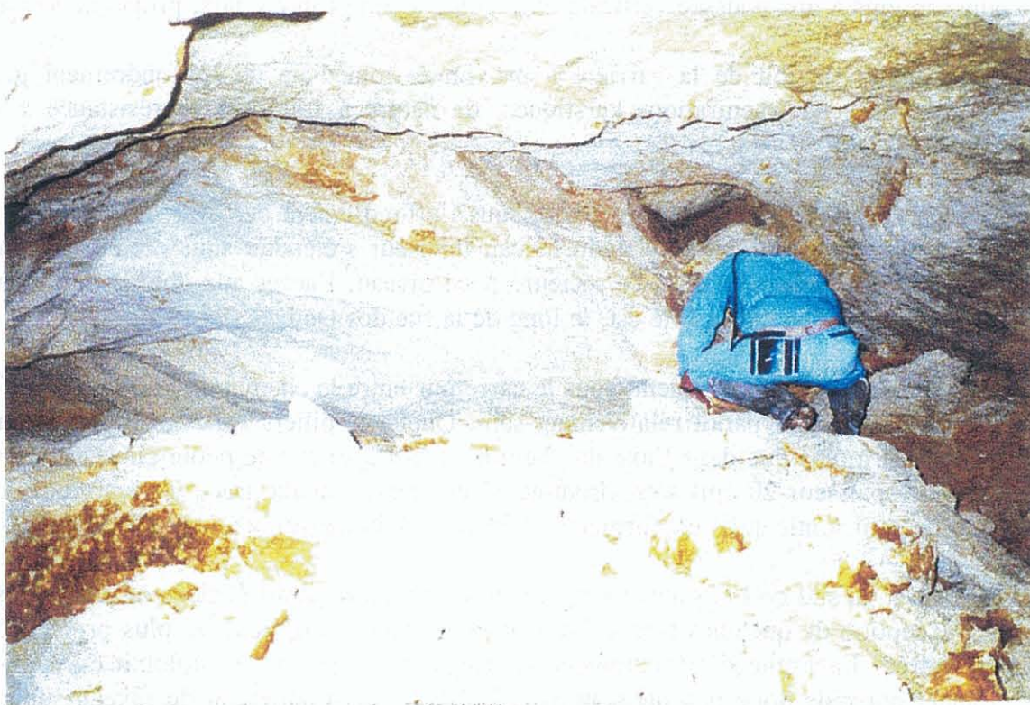
Figure 25 - Chute de toit importante, en bordure de l'effondrement de 1994 (vue prise au niveau inférieur)
