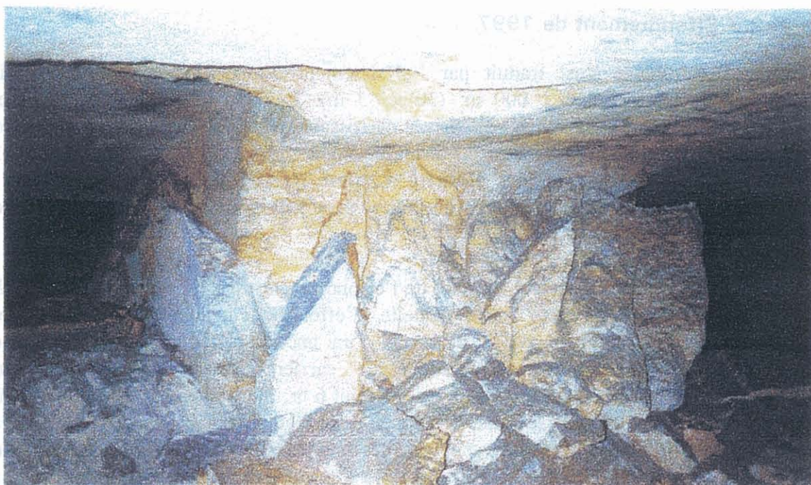
Figure 32 - Pilier éclaté et descente du toit de la carrière sous l'effet d'une surcharge verticale (niveau inférieur, sous le chemin de la Pège)
