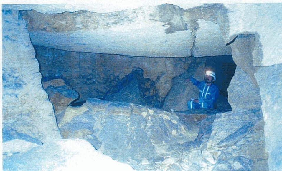
Figure 36 - Bordure de la zone foudroyée sous la parcelle AO 85 (Château Belair) au niveau supérieur
