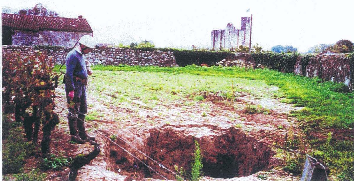
Figure 27 - Fontis apparu en surface dans les vignes de Château Canon, en bordure du chemin de la Pège, lors de l'effondrement de 1995
