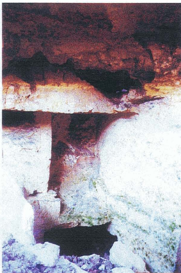
Figure 7 - Poche karstique stratiforme au dessus du toit du niveau superficiel de la carrière, en bordure est de l'effondrement de 1997 (niveau supérieur, cavité 2.2, et amorce du niveau superficiel en mezzanine, cavité 1.6)
