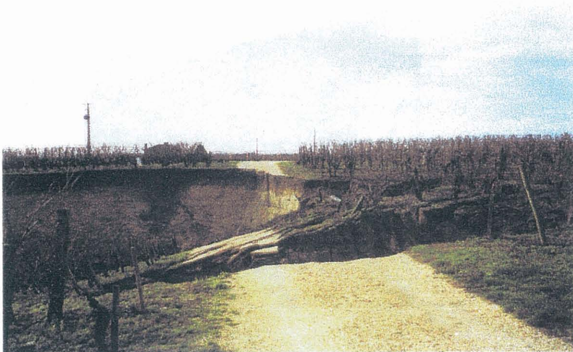
Figure 33 - Effondrement survenu en 1997 dans les vignes de Belair : aspect du bloc effondré, ayant entraîné la coupure d'un chemin carrossable
