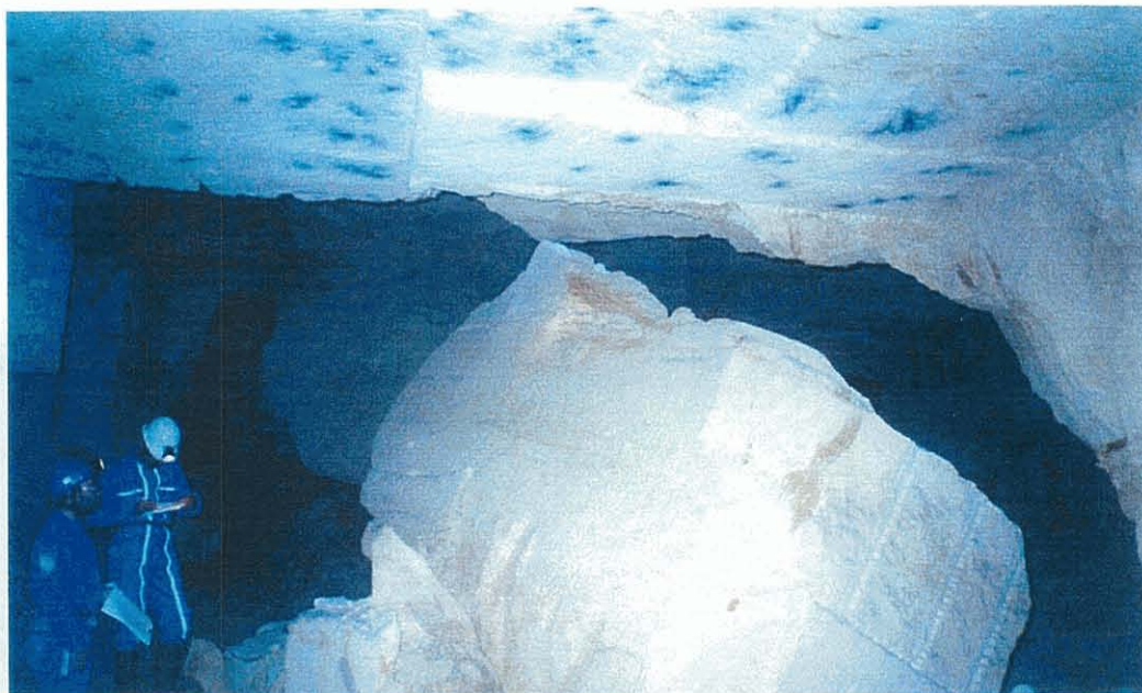
Figure 29 - Pilier détaché, dans une zone où le toit de la carrière ne présente pas de trace d'instabilité (niveau supérieur de carrière, sous le chemin de la Pège)
