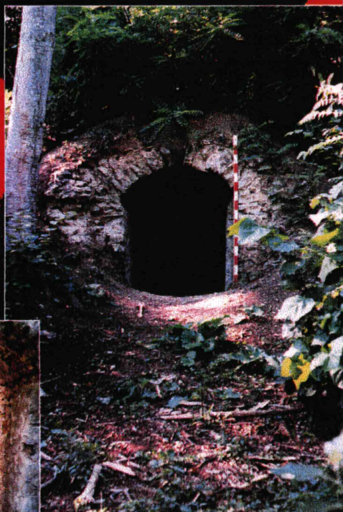
Glacière de La Bretauche, à Boigny-sur-Bionne, Loiret. Face au nord, l'entrée semi-enterrée présente une double porte, jouant le rôle de br. thermique.
