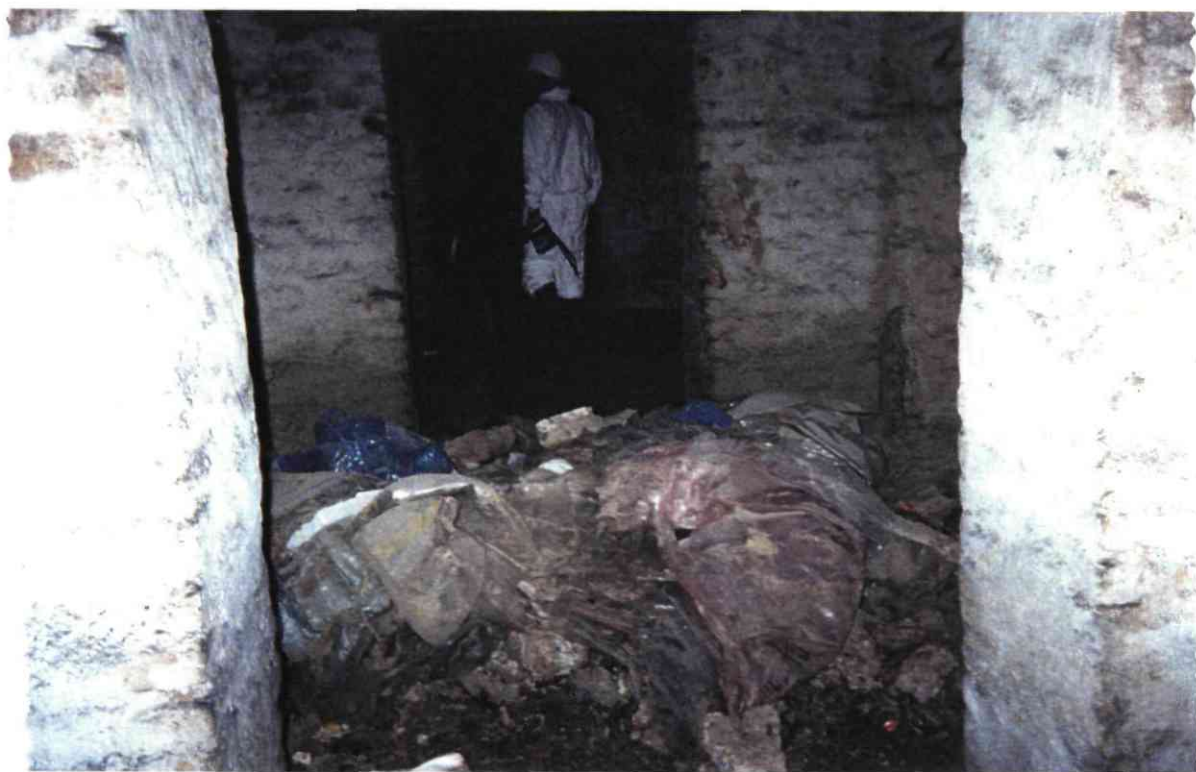
Rue de Champagne nord - Galerie 34. Déversement de déchets par ancienne cheminée
