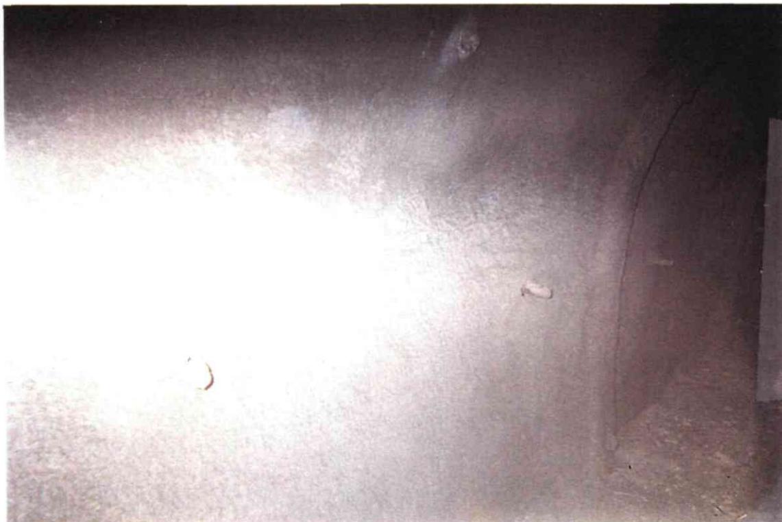
Rue de Champagne nord - Galeries 30 / 31. Boulonnage des tirants et béton projeté
