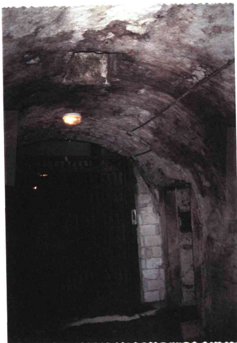
8, rue de champagne - Galerie 12, ascenseur et cheminée
