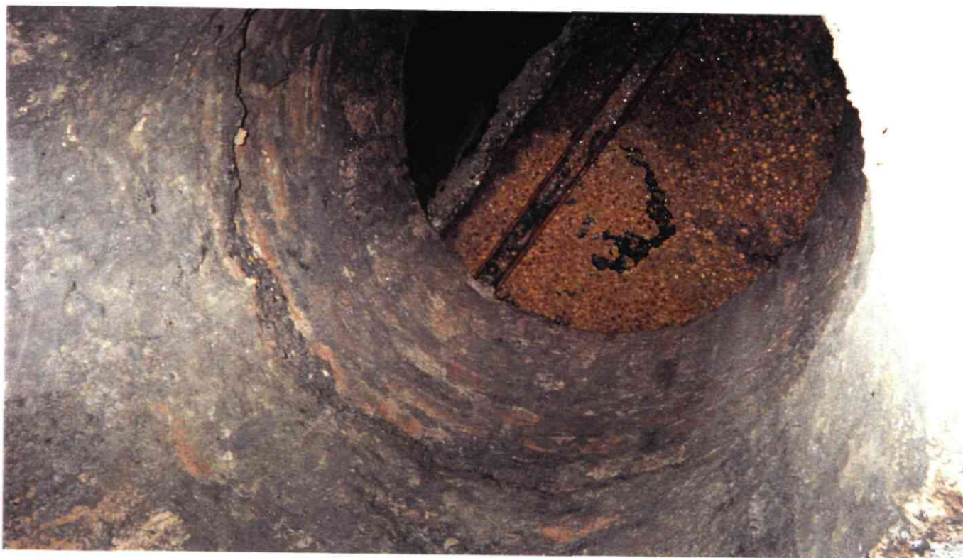
1, rue d'Epernay - Galerie 9. Cheminée par laquelle les déblais étaient déversés. Fermeture fragile
