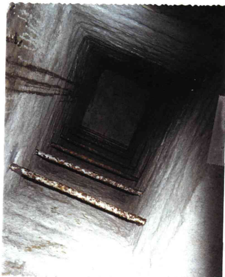
Rue de Champagne : Ancienne cheminée avec barreaux d'échelle
