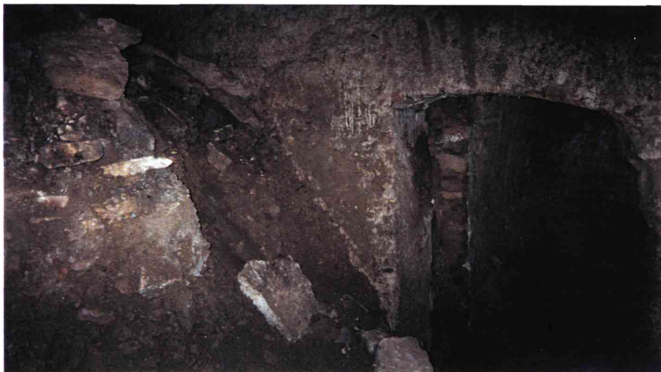
1, rue d'Epernay - Galerie 9 déblais de matériaux divers, passage vers galerie 10
