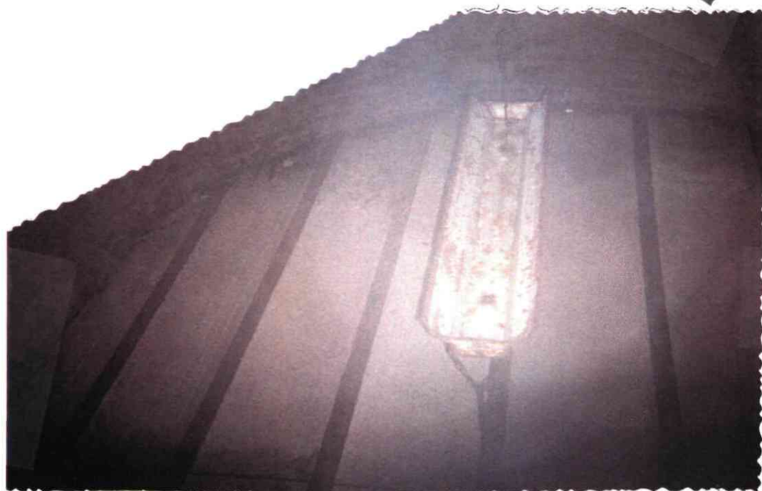
Galerie 16 - Plafond en béton et profilés de fer
