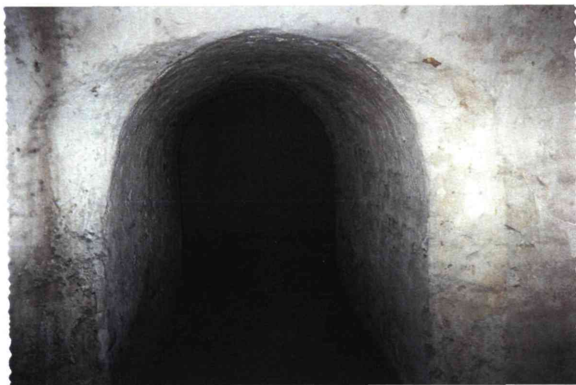
Rue de Champagne : Couloir de communication entre deux galeries
