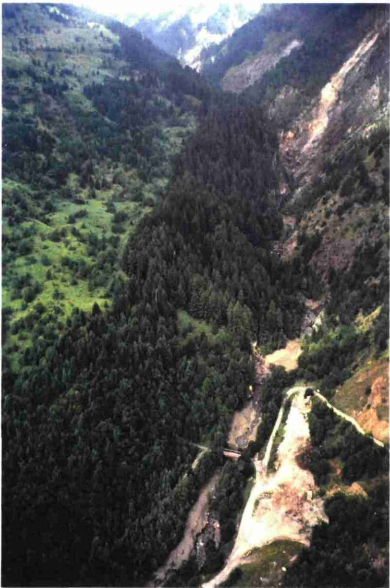
Fig. 4 - Vue de l'Arbonne ("le Pont-du-Génie").
