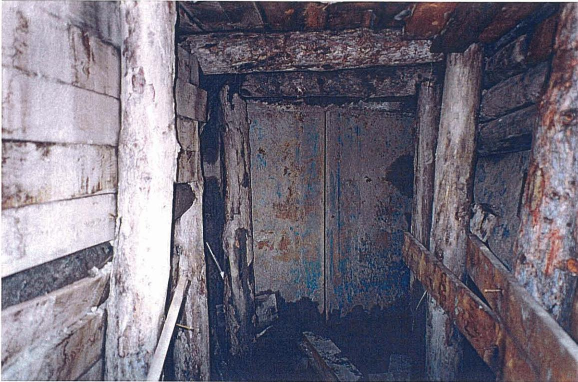
**Photo n°7: Concession de Closis, travers banc n° 2: vue de la porte métallique et du boisage récemment installés par les archéologues pour protéger l'entrée du travers banc.**
