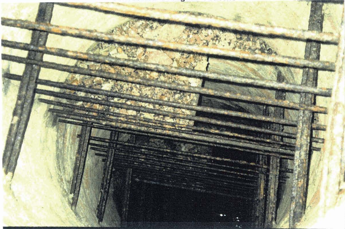
Photo 5 - Site 3 : Vue intérieure du puits, de la structure métallique et des plateformes du compartiment à échelle ; les échelles supérieures ont été enlevées.
