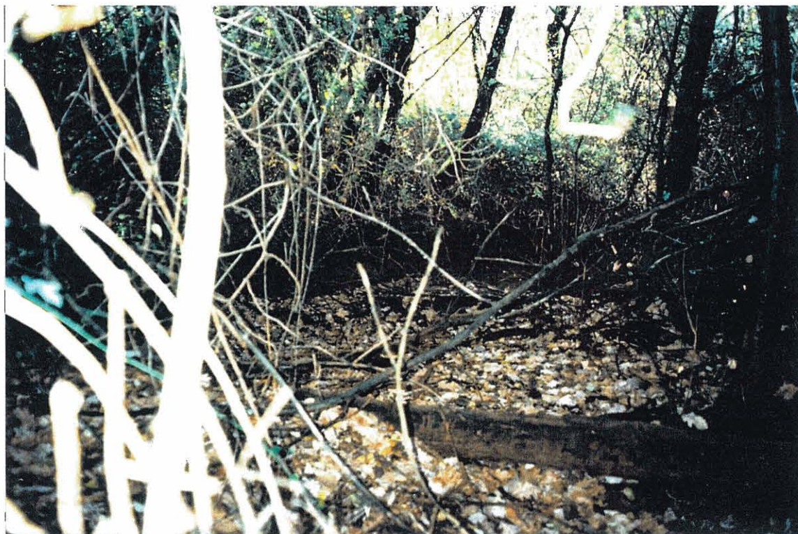
Photo 19 - Site 14 : Vue sur l'intérieur du dossier de décantation entouré d'une végétation dense. On distingue au fond le rebord intérieur du bassin, haut d'environ 1 m.
