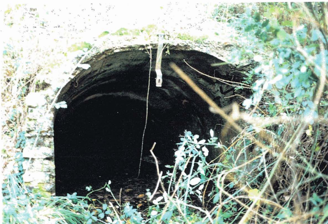
Photo 1 - Site 1 : Entrée de la descenderie étayée par une maçonnerie. La nappe affleure jusqu'au niveau de l'entrée.
