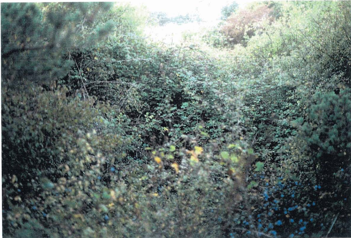
Photo 15 - Site 8 : Effondrement dans la haie de pruneliers qui marque la ligne de travaux d'exploitation de Champcrébat près de la surface.
