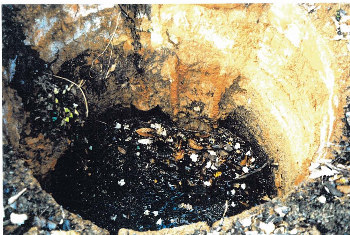
Photo 9 - Site 4 : Vue de l'intérieur du puits, après déblaiement. On aperçoit des vestiges d'équipement, plaqués contre la paroi.
