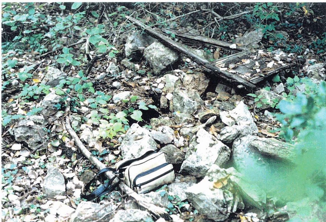
Photo 8 - Site 4 : Vue sur l'ouverture (tâche noire au centre de la photo) qui signalait la présence du puits masqué par des planches recouvertes de pierres et de végétation, avant leur déblaiement.
