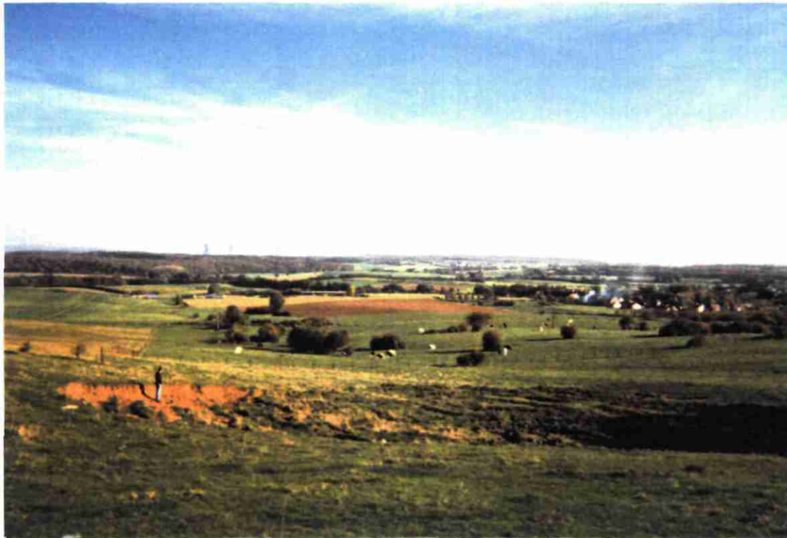
Photo N° 1 : Glissement rotationnel dans les schistes cartons du Toarcien (Kanfen)
