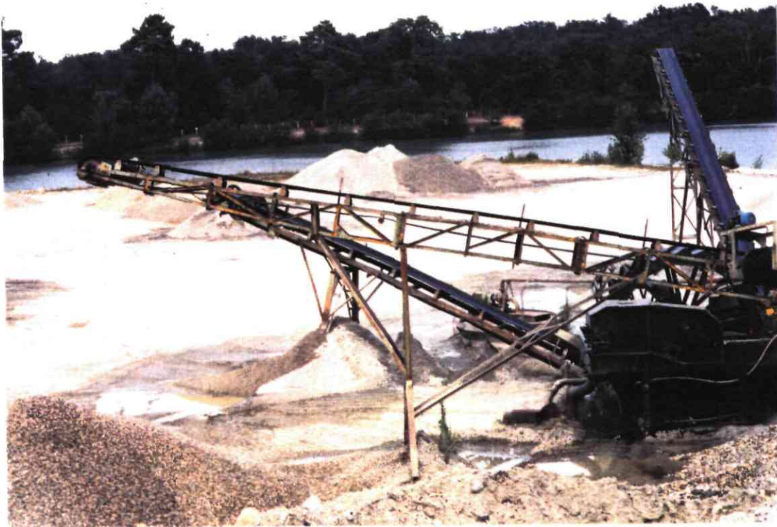
Ph. 7 - Alluvions de bas niveau (terrasse de Bègles) : extraction dans une gravière en eau.
