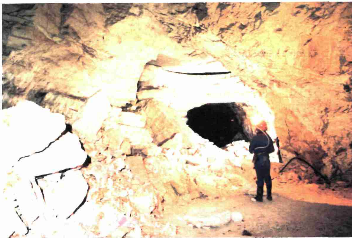
Rupture d'un pilier et flexion des bancs de toit.
