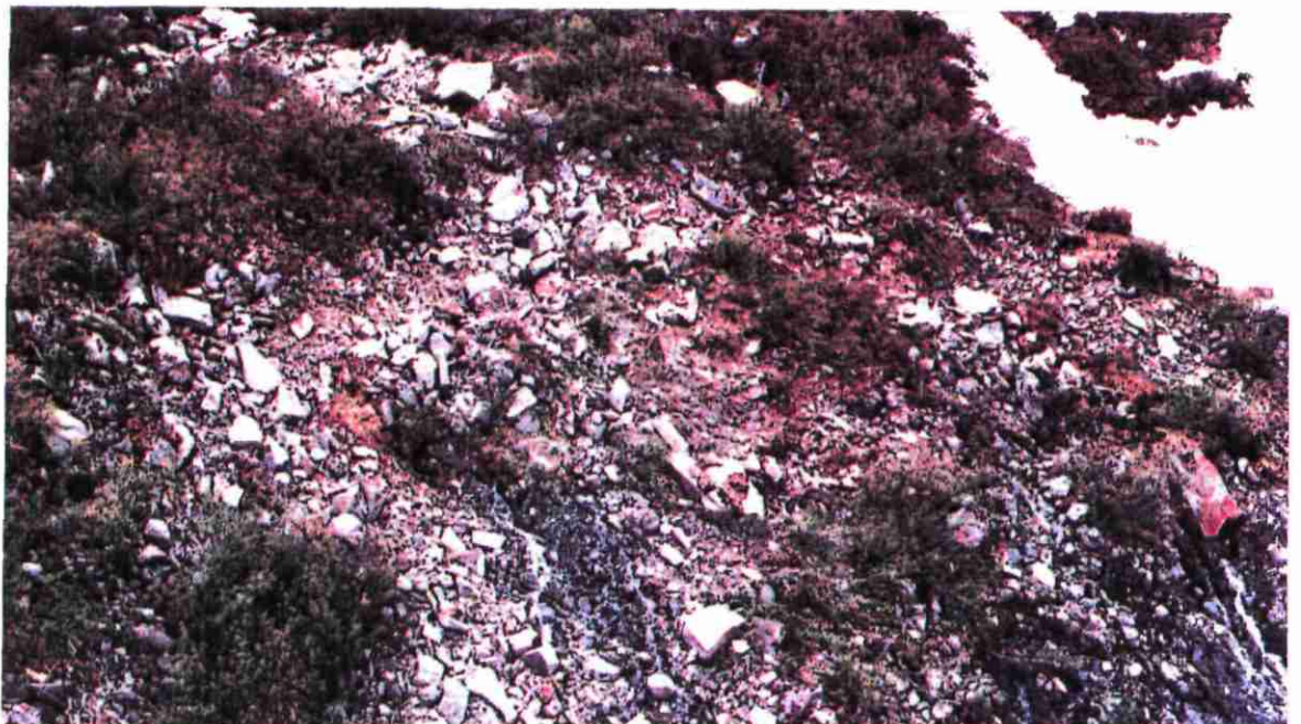
VUE RAPPROCHEE DE LA CREVASSE DUE AU TASSEMENT DES EBOULIS
