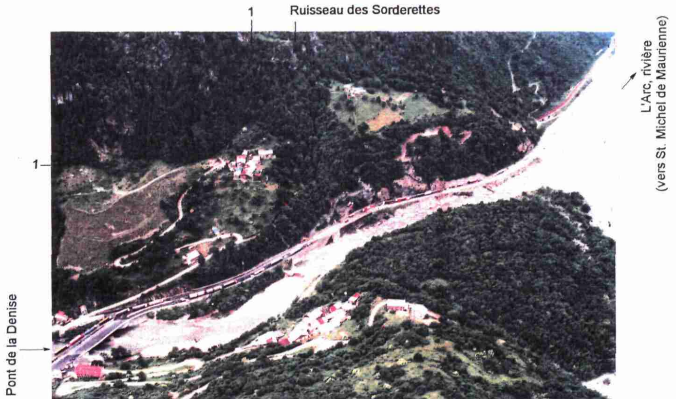
VUE GENERALE DE LA R.N.6 A L'AVAL DU PONT DE LA DENISE la position du véhicule sur la chaussée indique l'arrivée de la coulée de laves en 1 : hameau des Sordières, en haut, à droite : les Sorderettes
