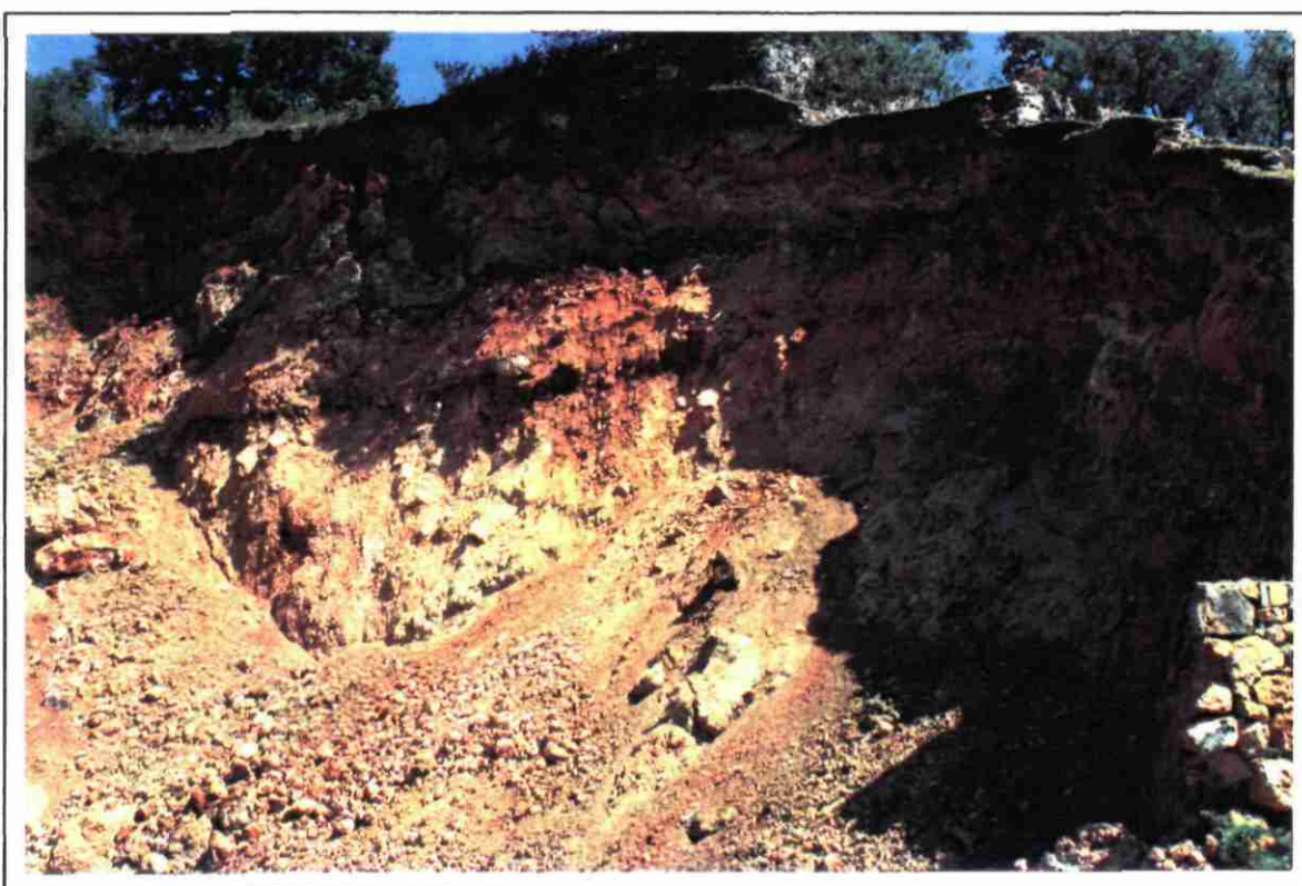
Fig. 8 - Effondrement de Bargemon
