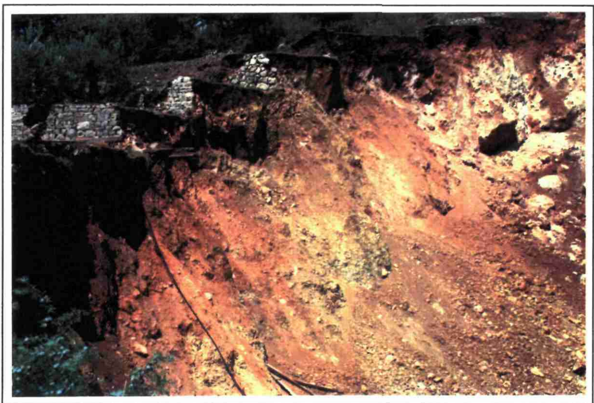
Fig. 6 - Effondrement de Bargemon
