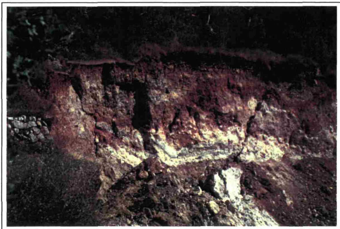
Fig. 6 - Evolution des parois de l'effondrement
