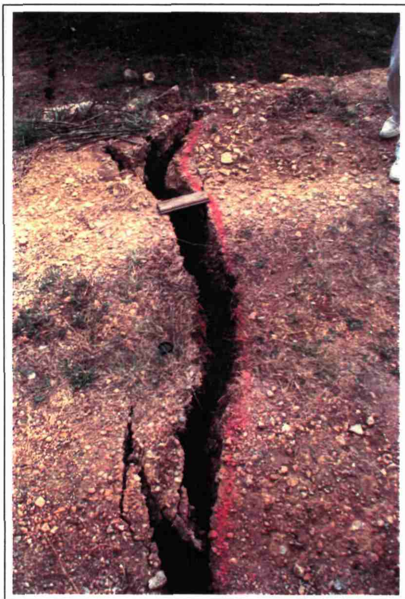
Fig. 12 - Evolution des fissures à proximité de la cavité
