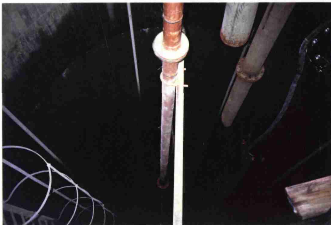
LAPRADE (station) : Vue axiale du puits à drains avec colonnes des pompes
