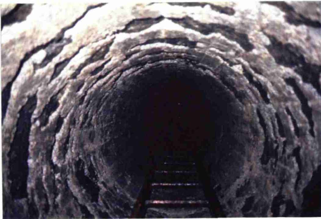
LAVERGNE-NEGRE : Cheminée d'aération n° 2 à 193 m, plus haute que la précédente, sans anomalie.
