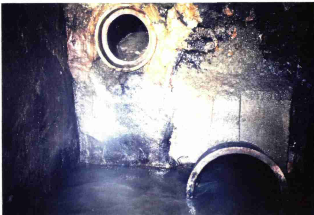
EMPRADES : Chambre de captage vue depuis le fil de l'eau
