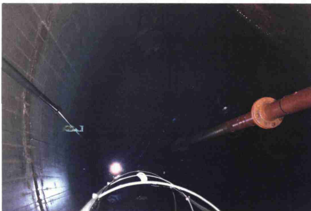
LAPRADE (station) : Niveau dynamique vers 8,50 m. En haut, ouverture du drain n° 3 à 11,50 m. A gauche, tringle du drain n° 2 (à 13,30 m)
