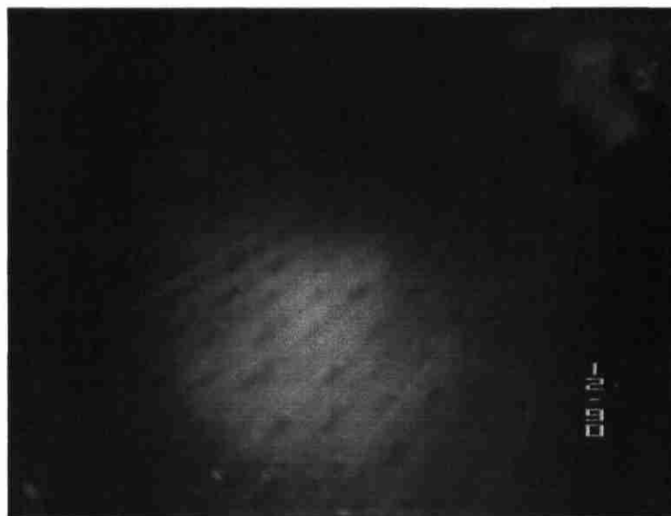
ARPAJON F7 : Vue de la paroi crépinée, avec lumières bien dégagées, Recouvrement fin de dépôts ferrugineux, alimentés par un écoulement supérieur (Purge colonne d'exhaure)
