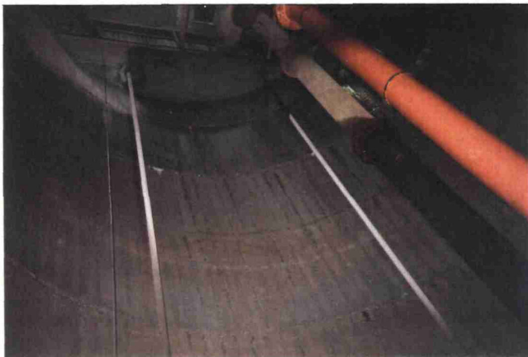
LAPRADE (station) : Paroi bétonnée du puits (diamètre 4 000 mm), commandes des drains n° 3 et 4 et exhaures des pompes
