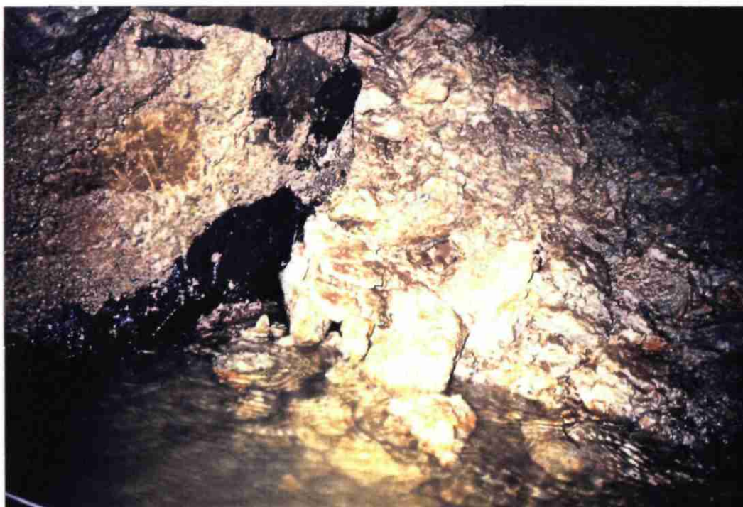
EMPRADES : Ouverture latérale dans la paroi Ouest, plusieurs mètres après l'entrée. Eboulis divers, humides et fil de l'eau en bas
