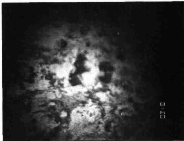
YTRAC (station) : Vue latérale du tubage, totalement recouvert par des incrustations ferriques. Traces de corrosion en cratère en bas à gauche
