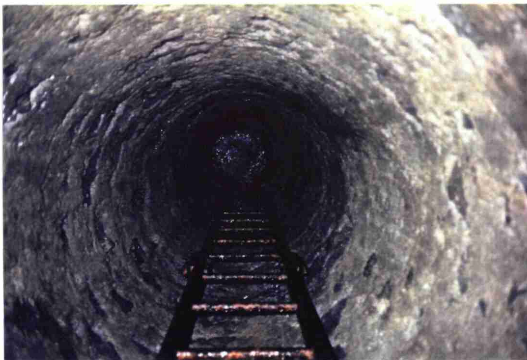
LAVERGNE-NEGRE : Cheminée d'aération n° 1, sèche. Pas d'infiltration, seulement condensation (105 m)
