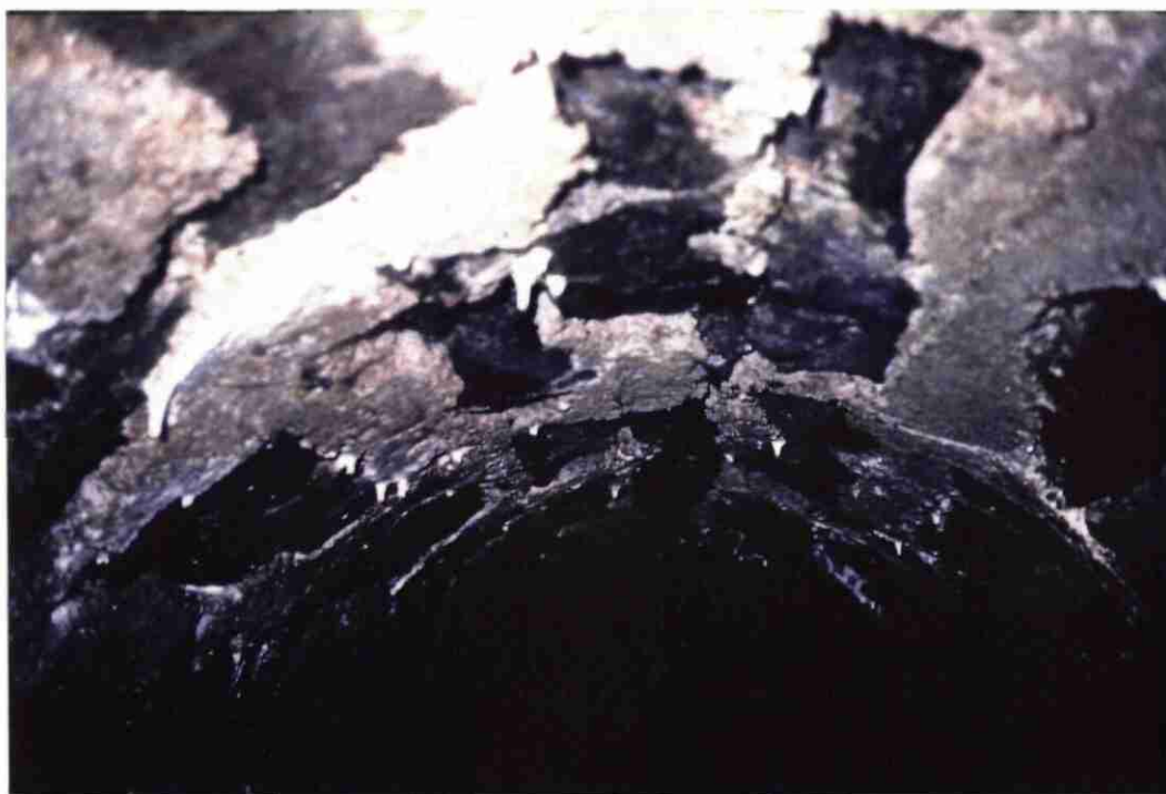
LAVERGNE-NEGRE : Traces de percolation par le toit vers 72 m
