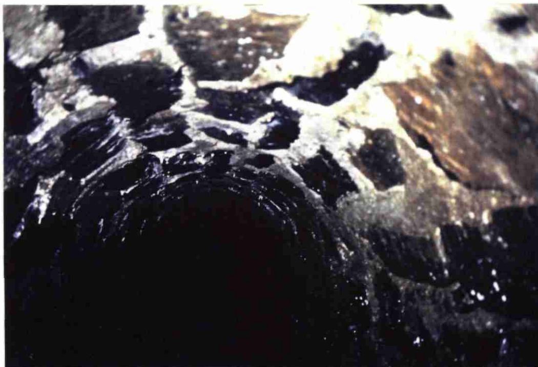
LAVERGNE-NEGRE : Détail de l'ogive, avec percolations très faibles et précipitation de calcite (vers 45 m)
