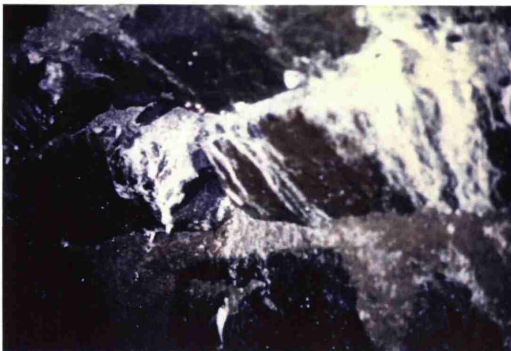
LAVERGNE-NEGRE : Traces de percolation par le toit vers 58 m
