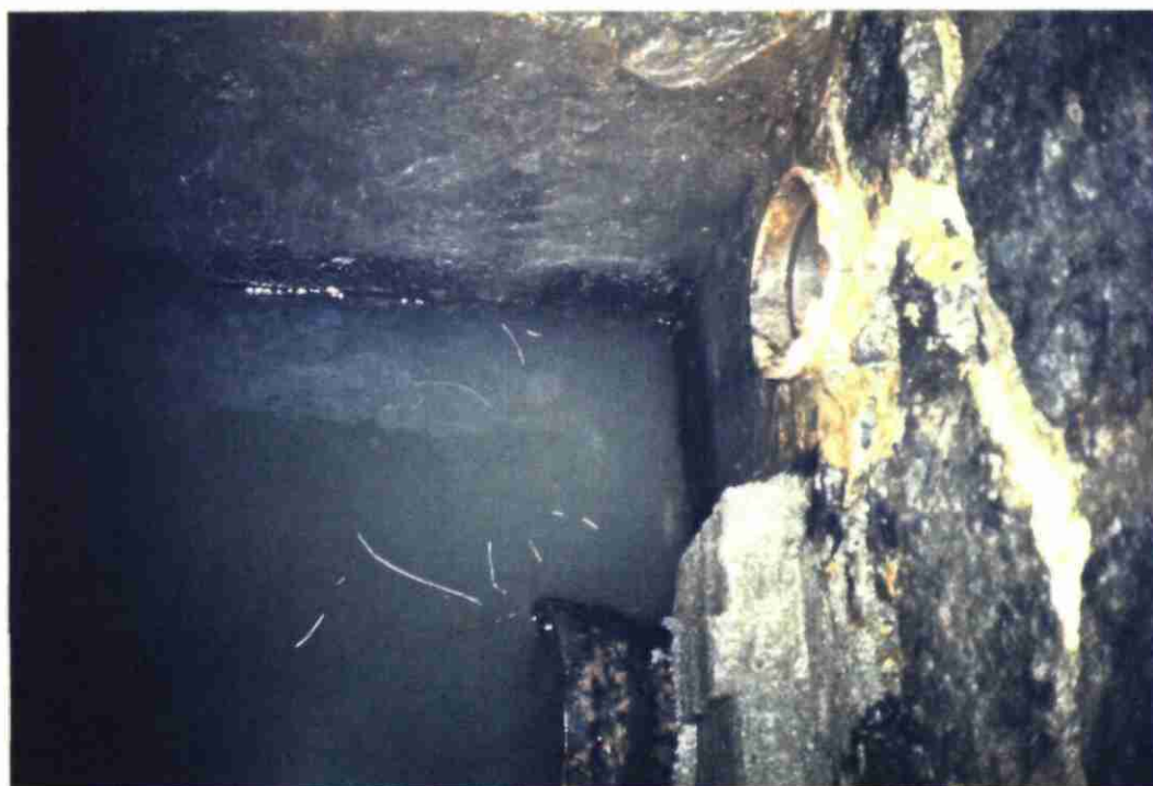
EMPRADES : Vue de la chambre de captage : en haut trop-plein ; en bas conduite d'exhaure (cliché pris avant les pluies de juin
