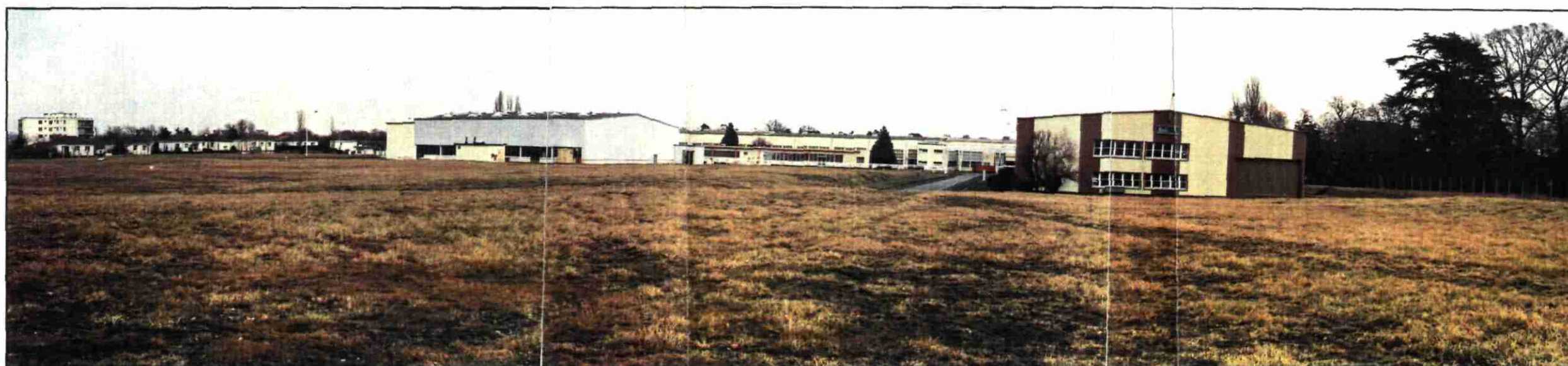
Fig.19 Vue panoramique vers le Nord-Ouest ; l'immeuble collectif se détache des maisons d'habitation ; aucun écran paysager ne sépare les maisons (ou la route) des bâtiments industriels.
