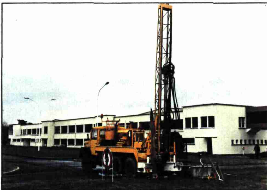
Fig.13 Installation de forage sur le site industriel
