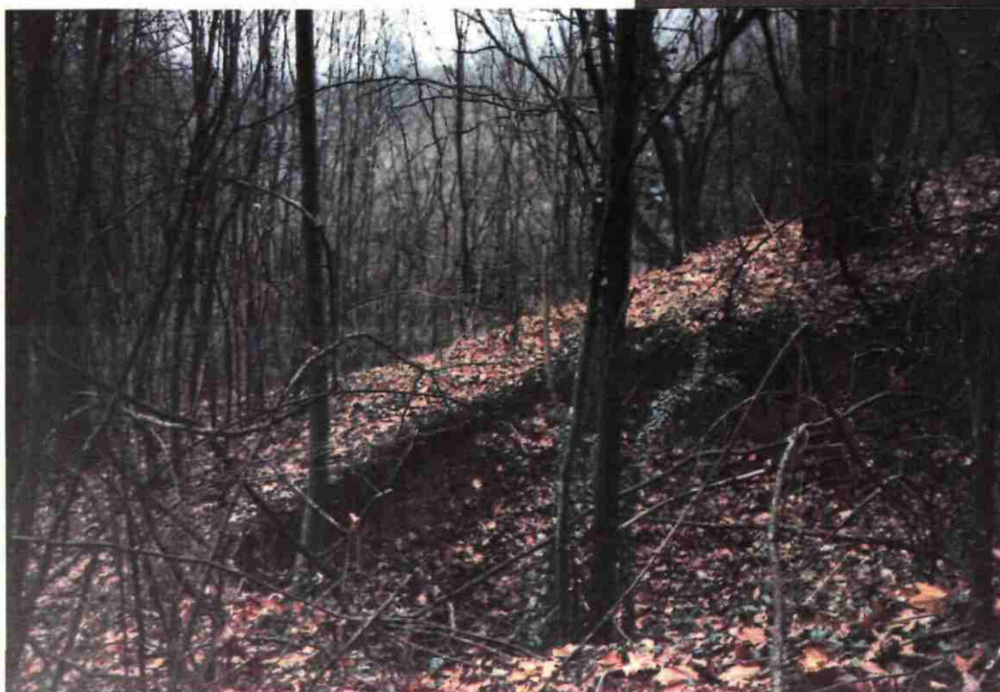
Effondrement et glissement de terrain
