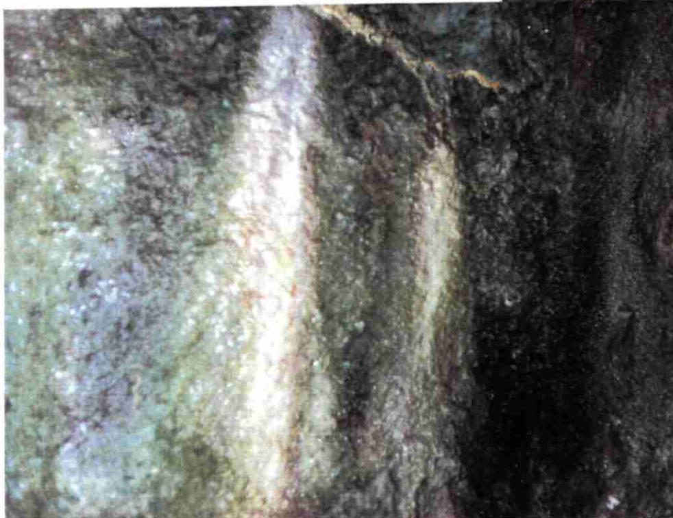
Dépôts calcaires et suintement.
