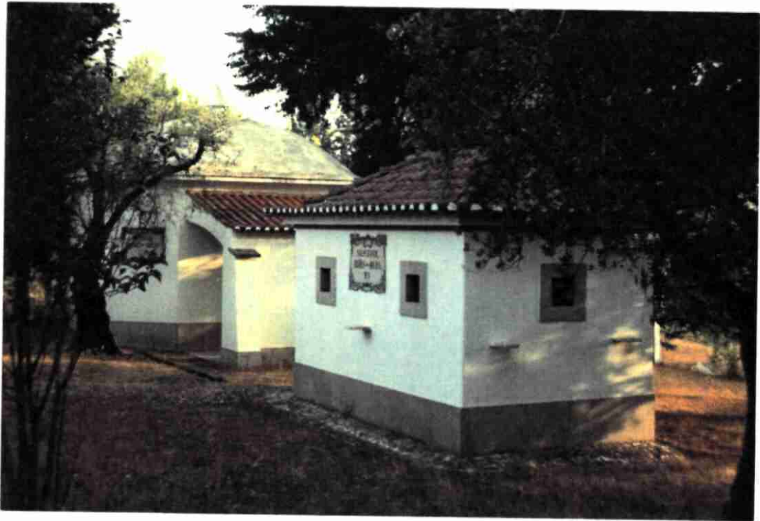
Fig. 7 - Puits n° 6 (au fond) et n° 5 (en avant).
