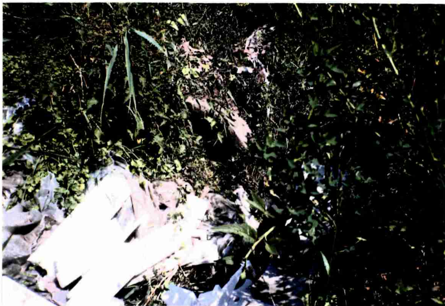
Photo 1 - Buse sous chemin d'accès au terril, partie nord près de la route 943a
