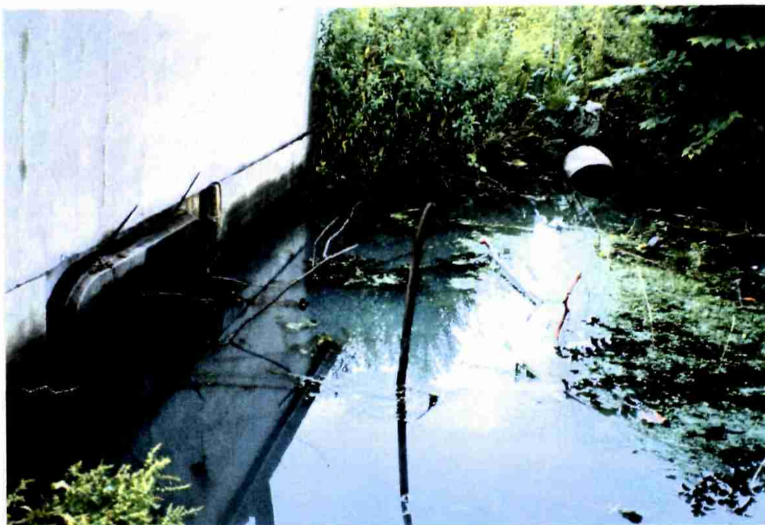
Photo 2 - Buse sous voie SNCF - partie nord
