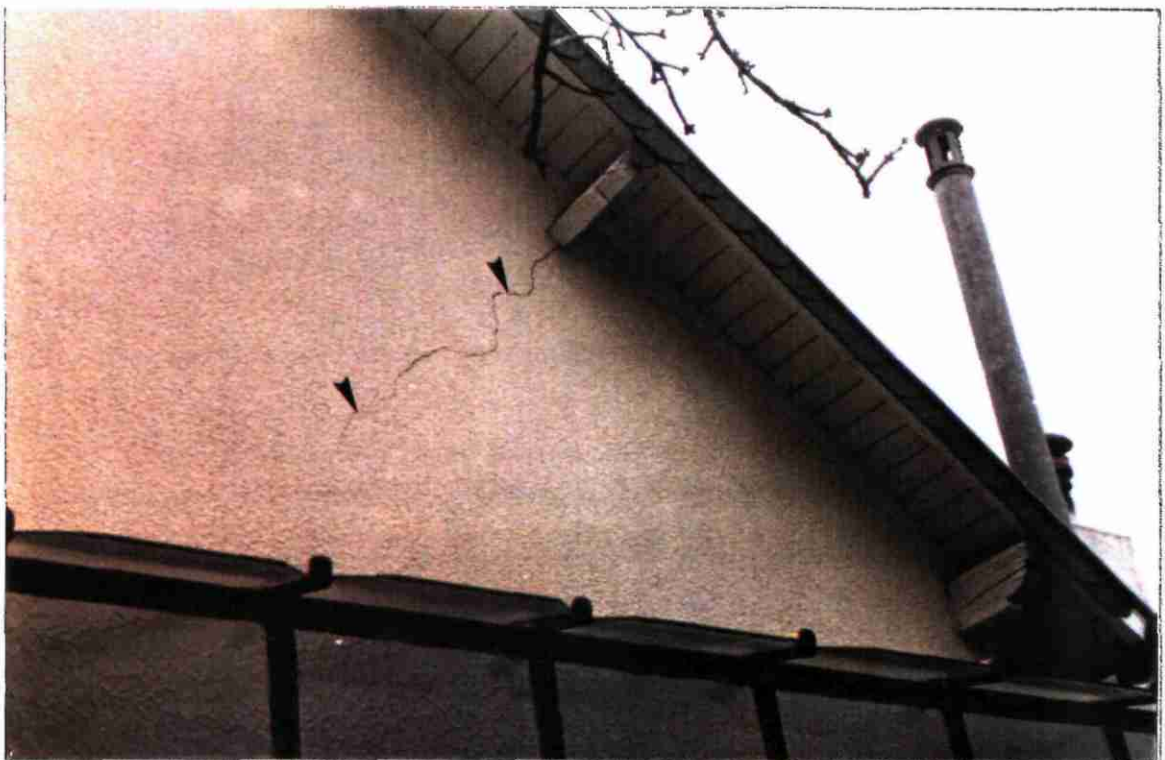
Propriété n°16 (GALON) 47, Rue Condorcet - Façade Sud-Ouest
