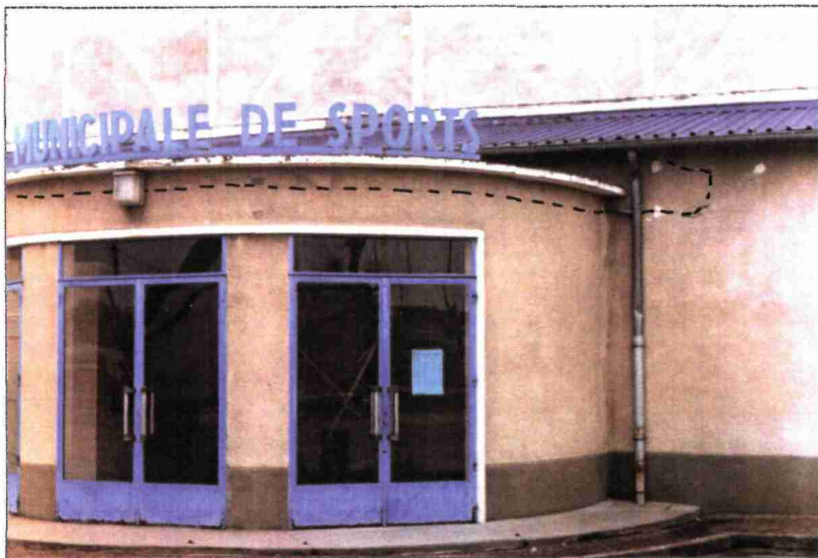
Propriété n°34 (MAIRIE) Rue Pablo Picasso - Façade Sud Salle Léo Lagrange
