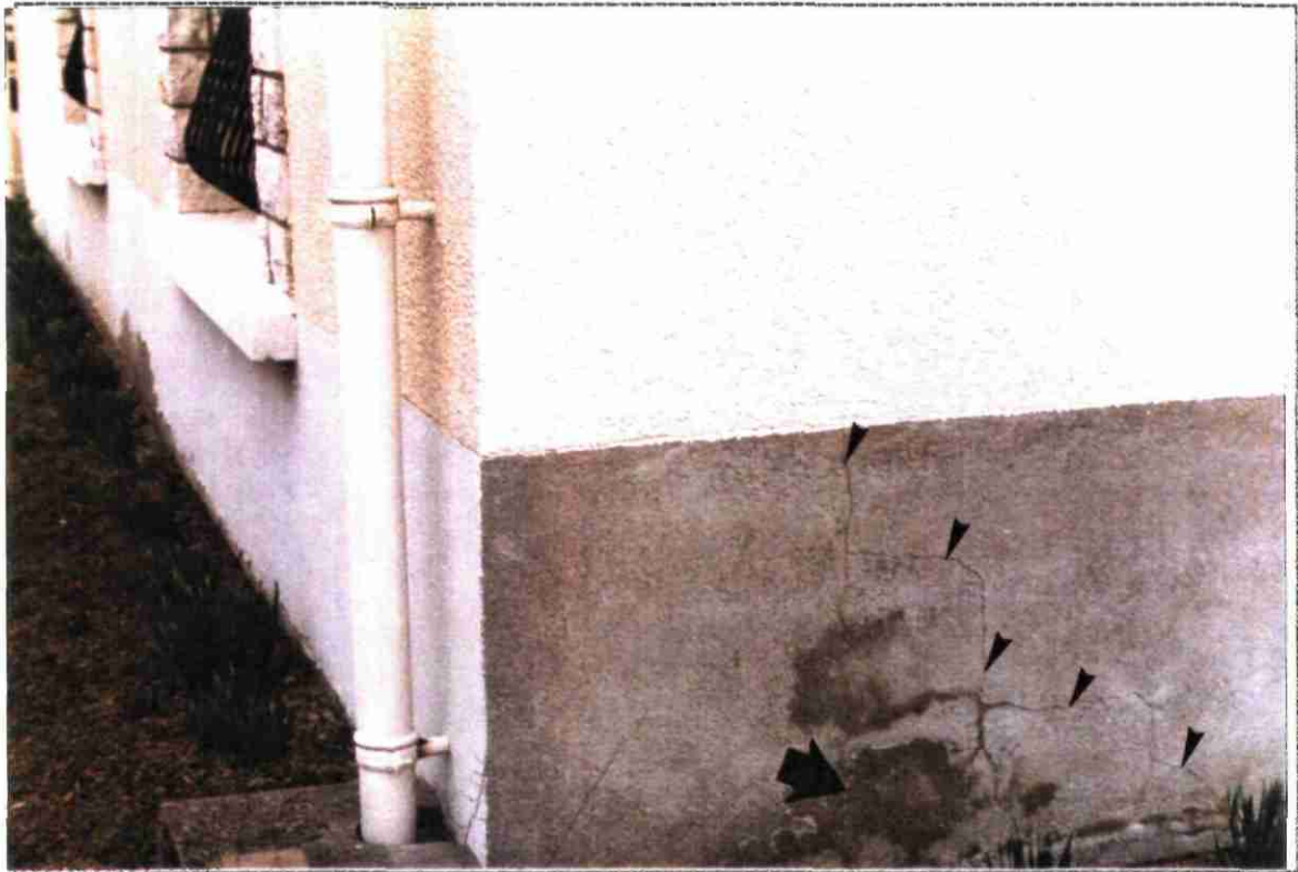
Propriété n°17 (BRAGARD) 54, Rue des Fossés - Façade Sud-Est Salle Léo Lagrange
