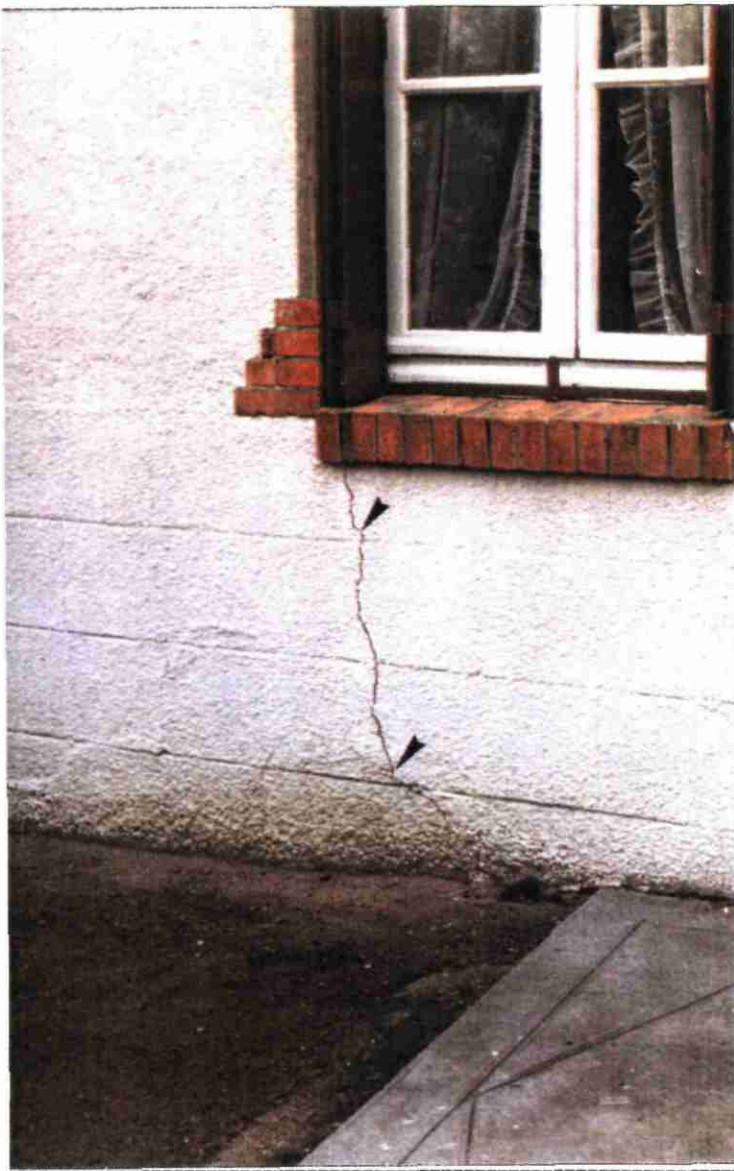
Propriété n°16 (GALON) 47, Rue Condorcet - Façade Sud-Ouest
