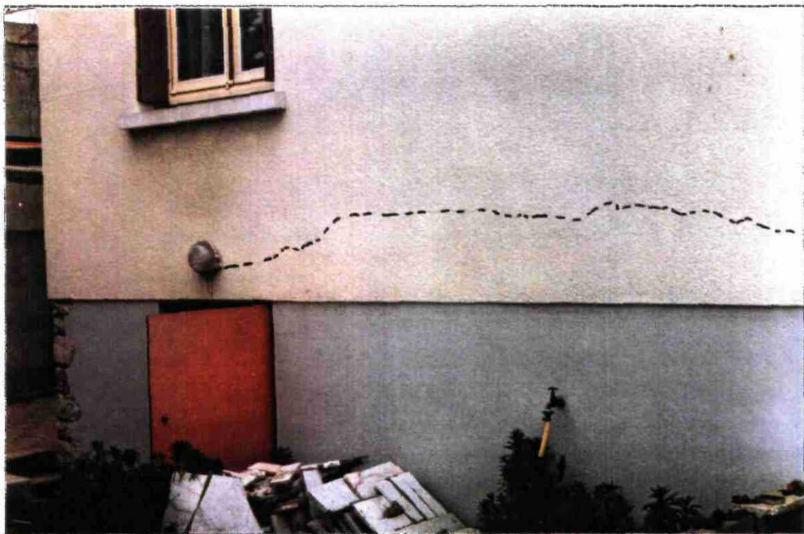
Propriété n°13 (PAPET) 2, Rue René Ferragu - Façade Nord
