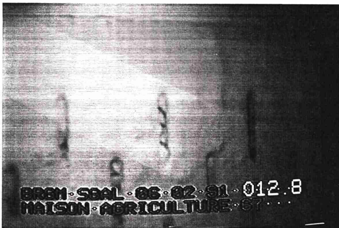
Tête de crépine non colmatée avec gravier filtre visible dans le fond des fentes
