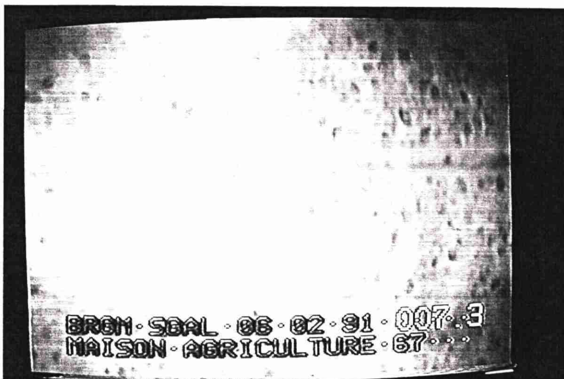
Tube plein en tête de forage avec paroi légèrement corrodée
