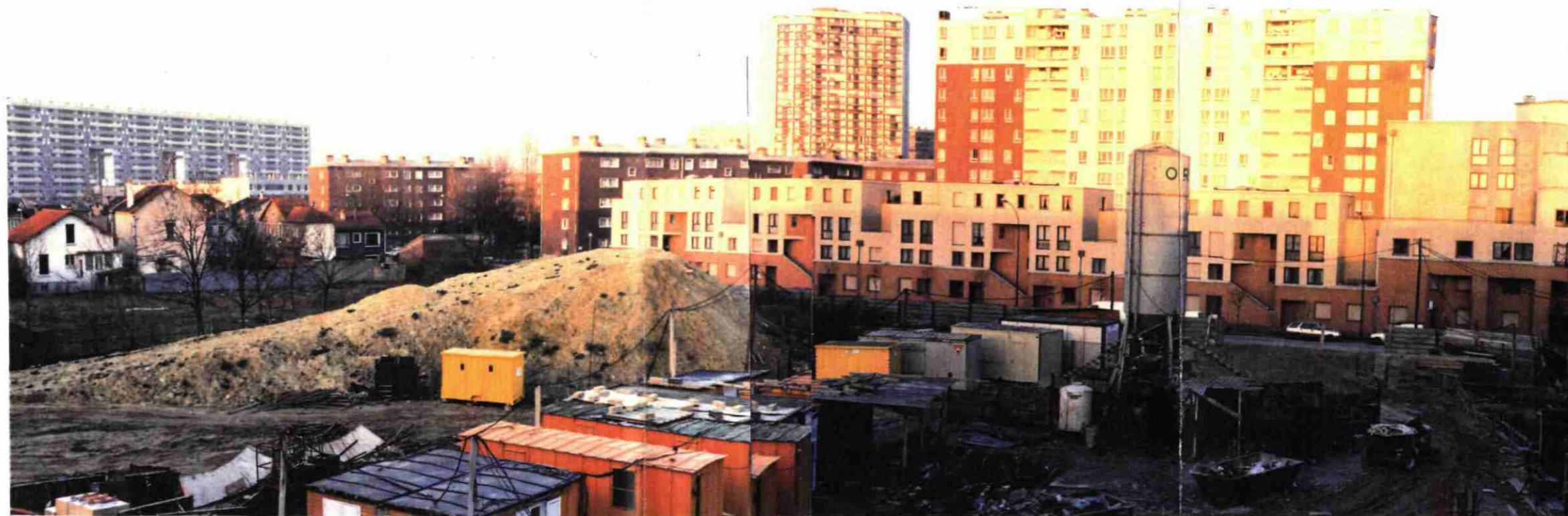
VUE DU SITE EN DIRECTION DE L'OUEST A l'arriere plan les immeubles longent la rue du Moulin Neuf.
