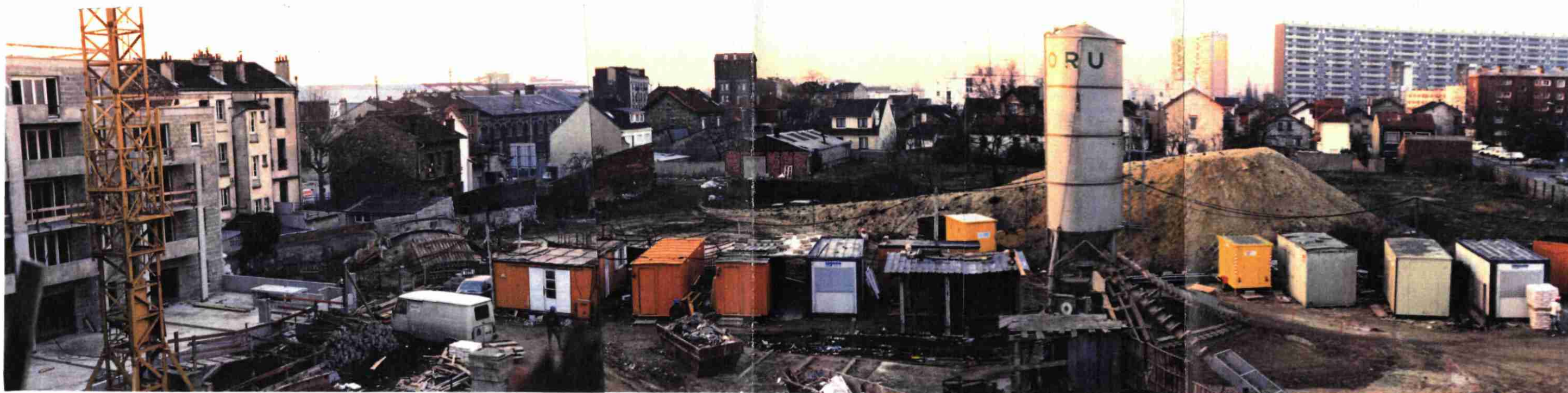
VUE DU SITE EN DIRECTION DU SUD Les habitations qui bordent le site sont ici de type individuelle.
