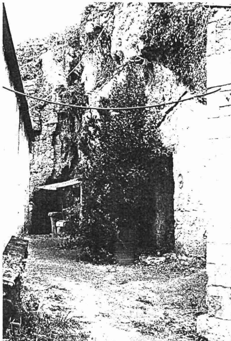
Vue sur l'écaille et l'entrée de carrière Purge de blocs, colmatage fissure, fermeture d'accès
