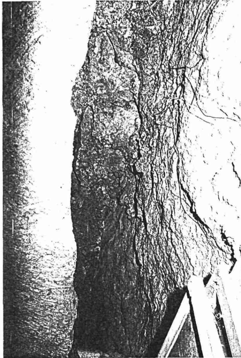
Cavité souterraine - Vue de la fracture ouverte (0,80 m) Soutènement par pilier Ancrage paroi falaise Fermeture de l'accès
