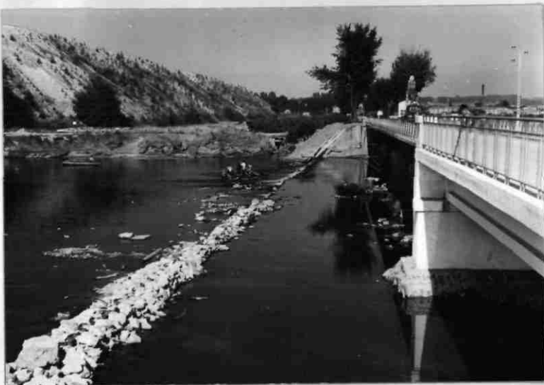
Rosières - pont de la route de contournement
