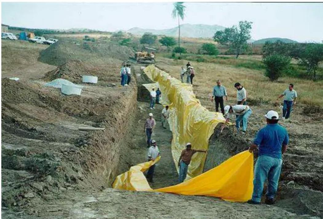
*Illustration 32 : Construction d'une barrière physique souterraine rustique au Brésil (Shubo, 2020).*
