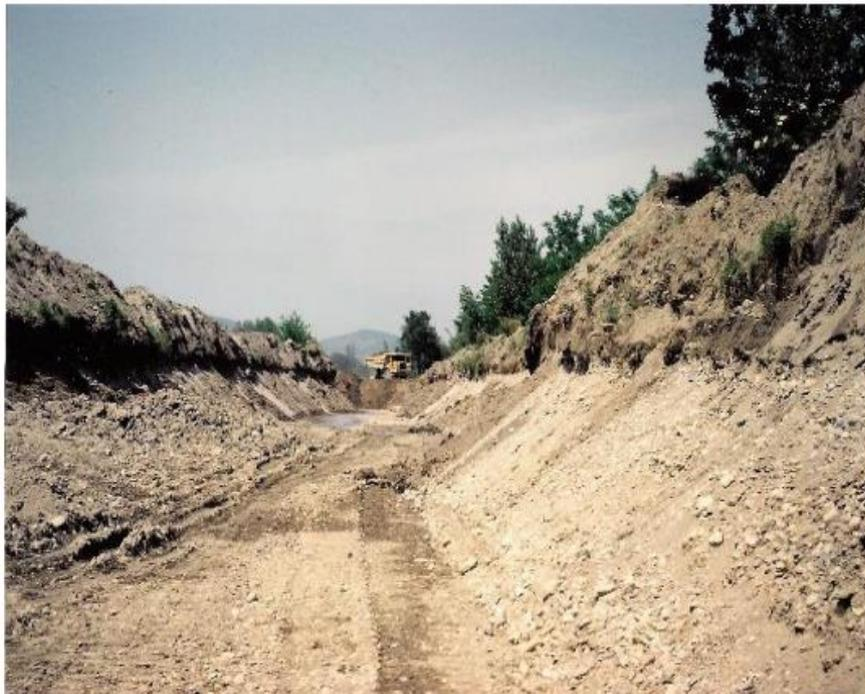
*Illustration 12 : Barrière physique souterraine en cours de construction à Massillargues-Attuech (Gard - France). Tranchée, en cours de réalisation, hors d'eau, avant pénétration dans la nappe. (Masson, 2018).*
