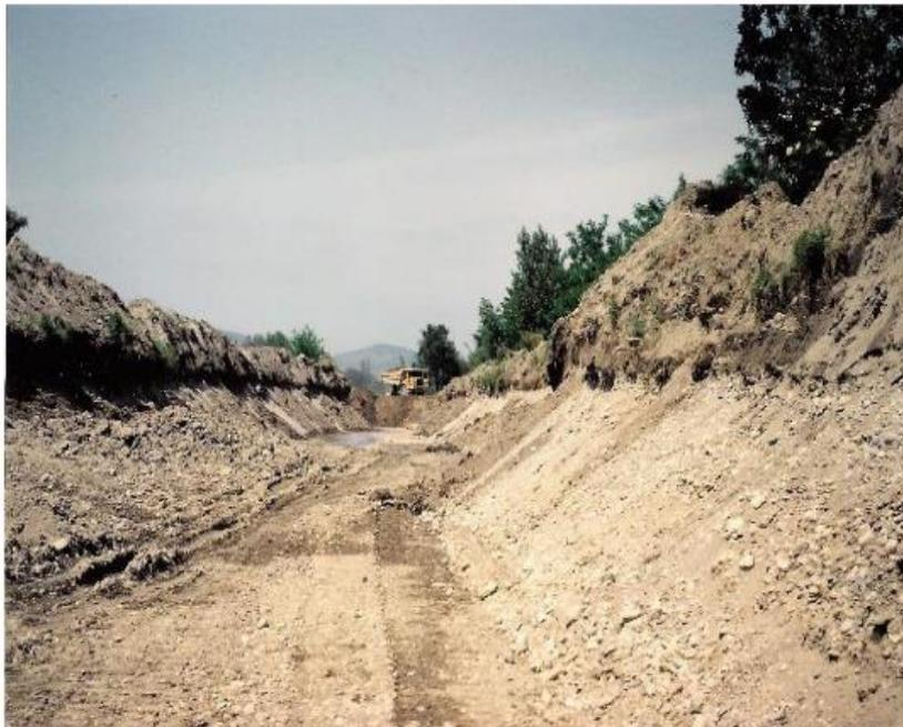
*Illustration 97 : Barrière physique souterraine en cours de construction à Massillargues-Attuech (Gard - France). Tranchée, en cours de réalisation, hors d'eau, avant pénétration dans la nappe. ((Masson, 2018).*
