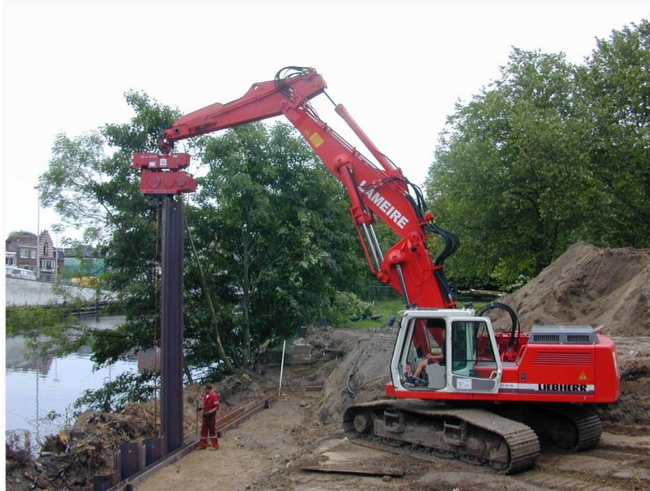
*Illustration 39 : Installation de palplanche par vibro-hammer sur une berge (Arcelor-Mittal).*
