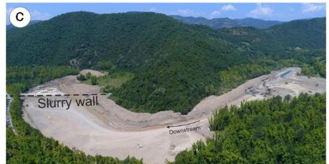
Illustration 9 : Implantation en travers d'un aquifère alluvial d'une barrière physique souterraine à occultation latérale complète à Bahçecik en Turquie (Apaydin, 2023).
