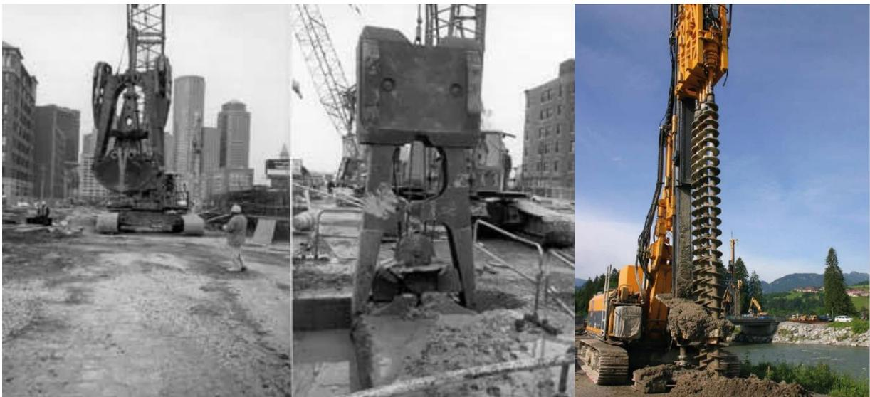
Illustration 48 : Différents types de machines utilisés pour la mise en place de parois en « Mélange de Sol » : benne preneuse (gauche), hydrofraise (milieu) et DSM (droite) - (Bauer).
