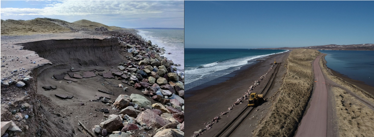
Illustration 2 : A) Encoche d'érosion et B) travaux sur l'isthme de Miquelon-Langlade suite aux tempêtes de février-mars 2021 (source : photo et extrait du vol drone DTAM 2021).
