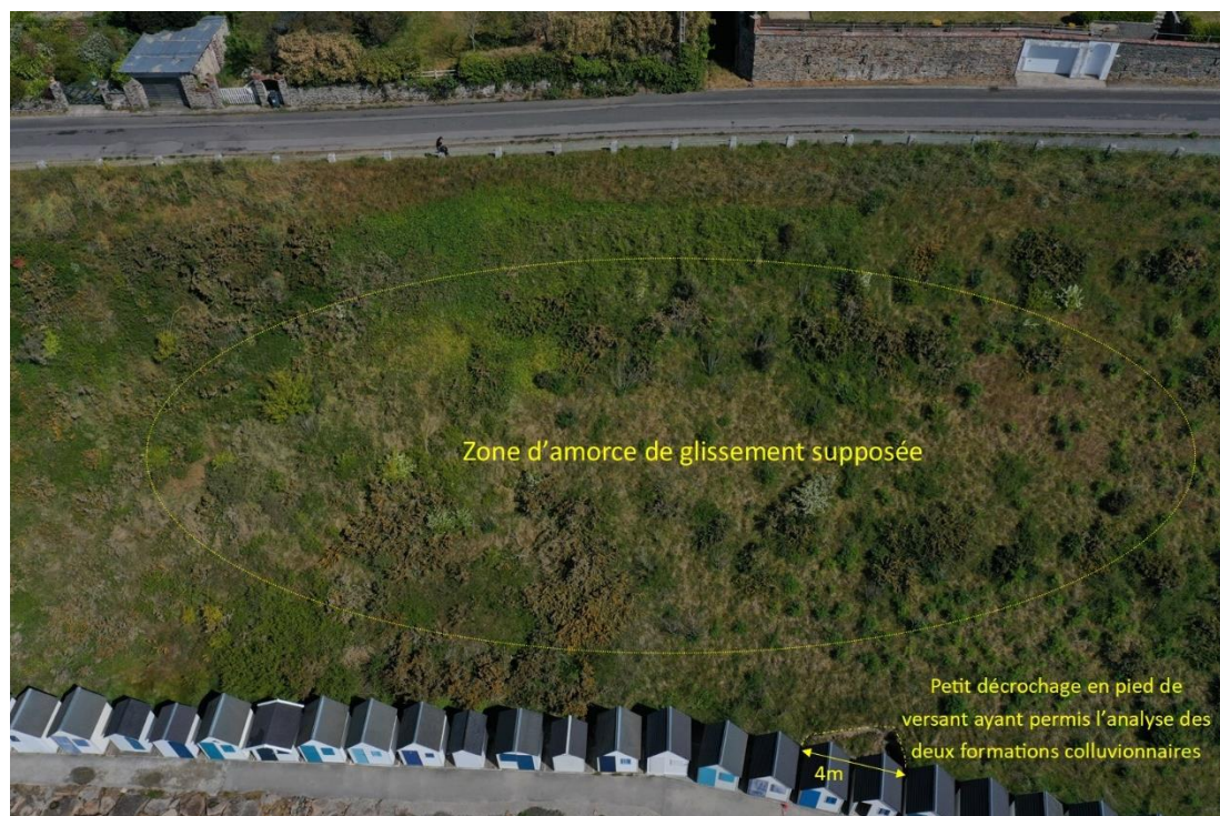
Illustration 39 : Seconde zone supposée d'amorce de glissement à l'arrière des cabines de plage (BRGM, Mai 2021)
