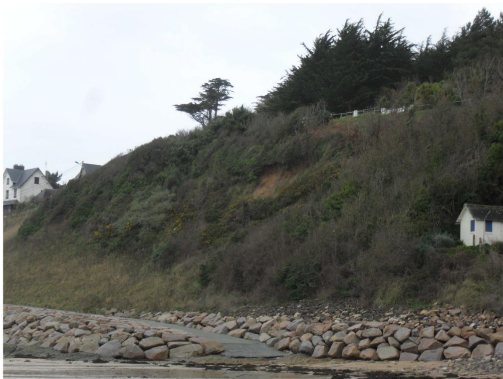
Illustration 17 : Glissement de formations superficielles entre le restaurant et la digue/enrochement, au droit de la route de la Corniche (photo mairie 2012)
