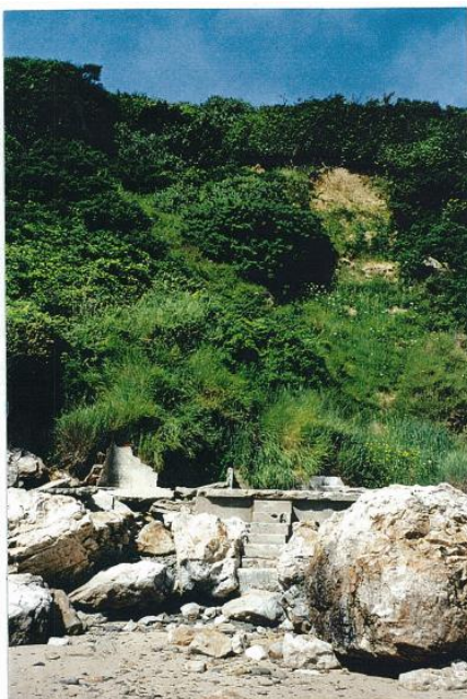
Photo 6 - La cabane 198 (section AM) entièrement détruite par les éboulis et arasée depuis le cône d'éboulis est encore visible. Les zones ayant connu des désordres récents sont visibles par l'absence de végétation arbustive (en 1995) et la mise à nu par décapement superficiel en 1999/2000.
