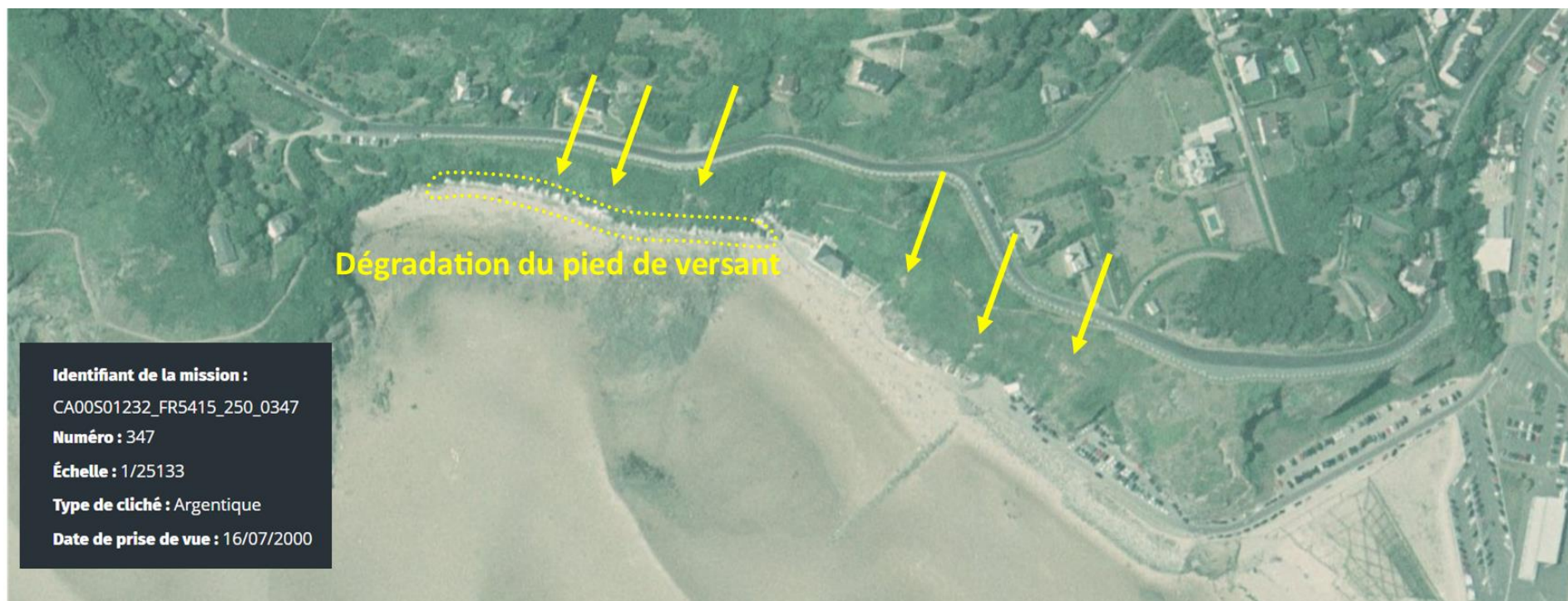
Illustration 22 : Photographie aérienne IGN de 2000, les flèches jaunes matérialisent l'emplacement de loupes de glissement
