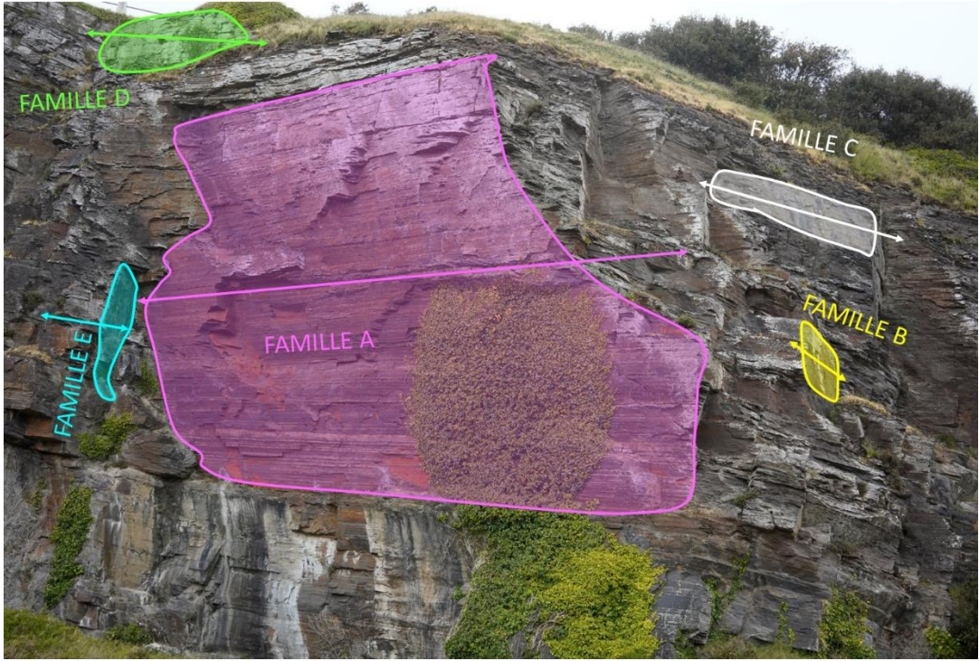
Illustration 44 : Représentation des différentes familles de fractures sur une photographie du secteur S2, hauteur de paroi environ 20 m (BRGM, Mai 2021)
