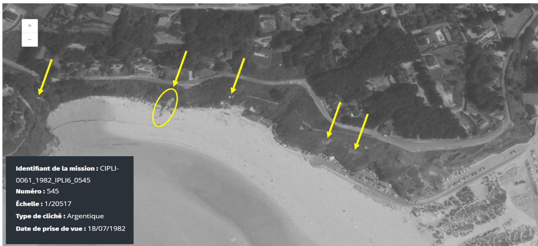
Illustration 21 : Photographie aérienne IGN de 1982, les flèches jaunes matérialisent l'emplacement de loupes de glissement
