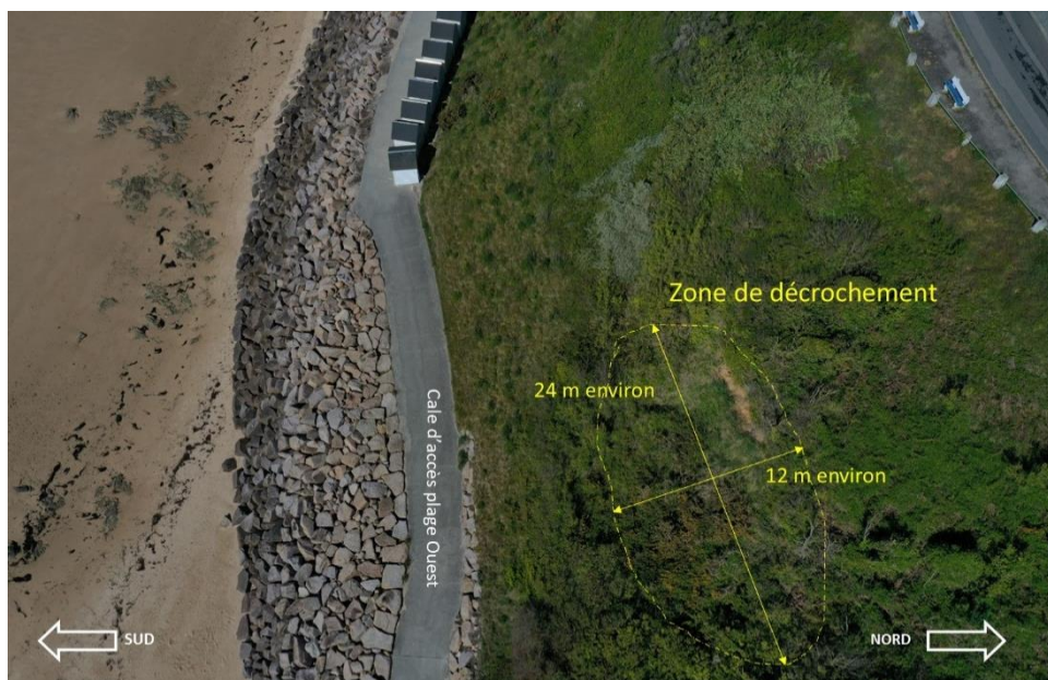
Illustration 38 : Vue aérienne de l'amorce de glissement situé au-dessus de la cale d'accès plage ouest (BRGM, Mai 2021)
