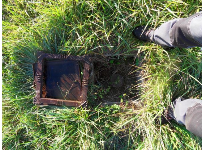
Figure 12 : Photographie de la tête d'ouvrage de la station 01381X0070/P25 (Bertrange, 57)
