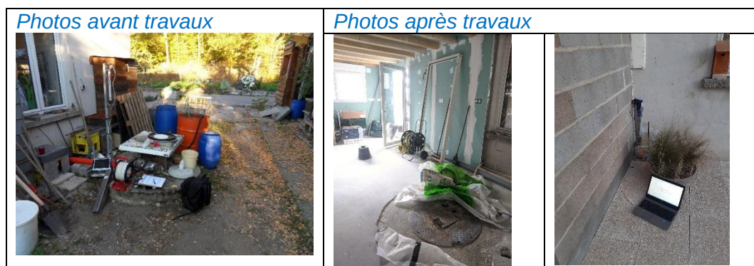
Figure 11 : Photographies du remplacement du matériel de l'ouvrage « 02303X0065/P » (Amance, 54) et déport de la télétransmission
