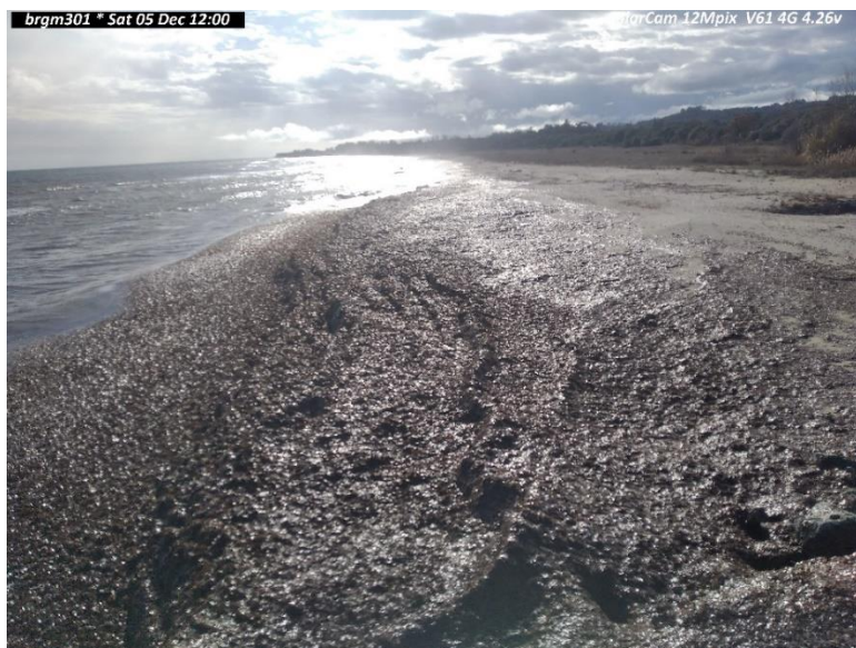
Figure 45 : Plage au sud du port de Taverna le 05-12-2020 à midi ; une large banquette recouvre la plage accolée à la digue sud du port de Taverna.
