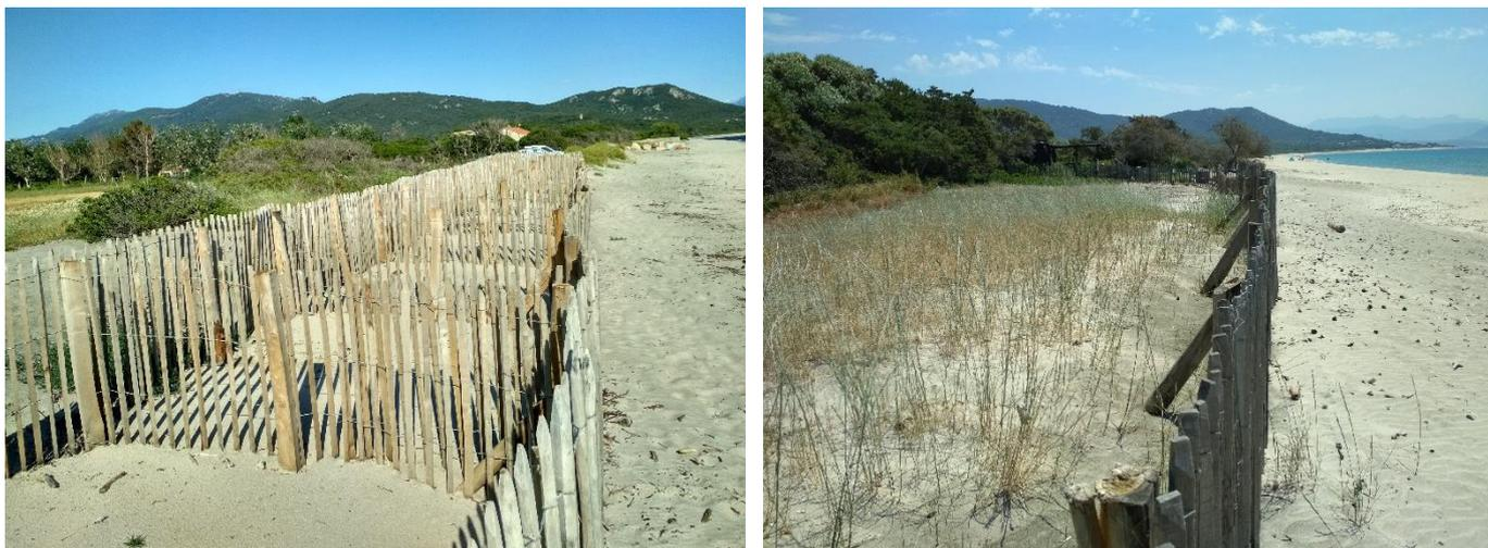
Figure 111 : Exemple de réaménagement du cordon dunaire sur le site Natura 2000 de Taravo (pièges à sable juin 2020 à gauche, ganivelles et plantation juin 2021 à droite).
