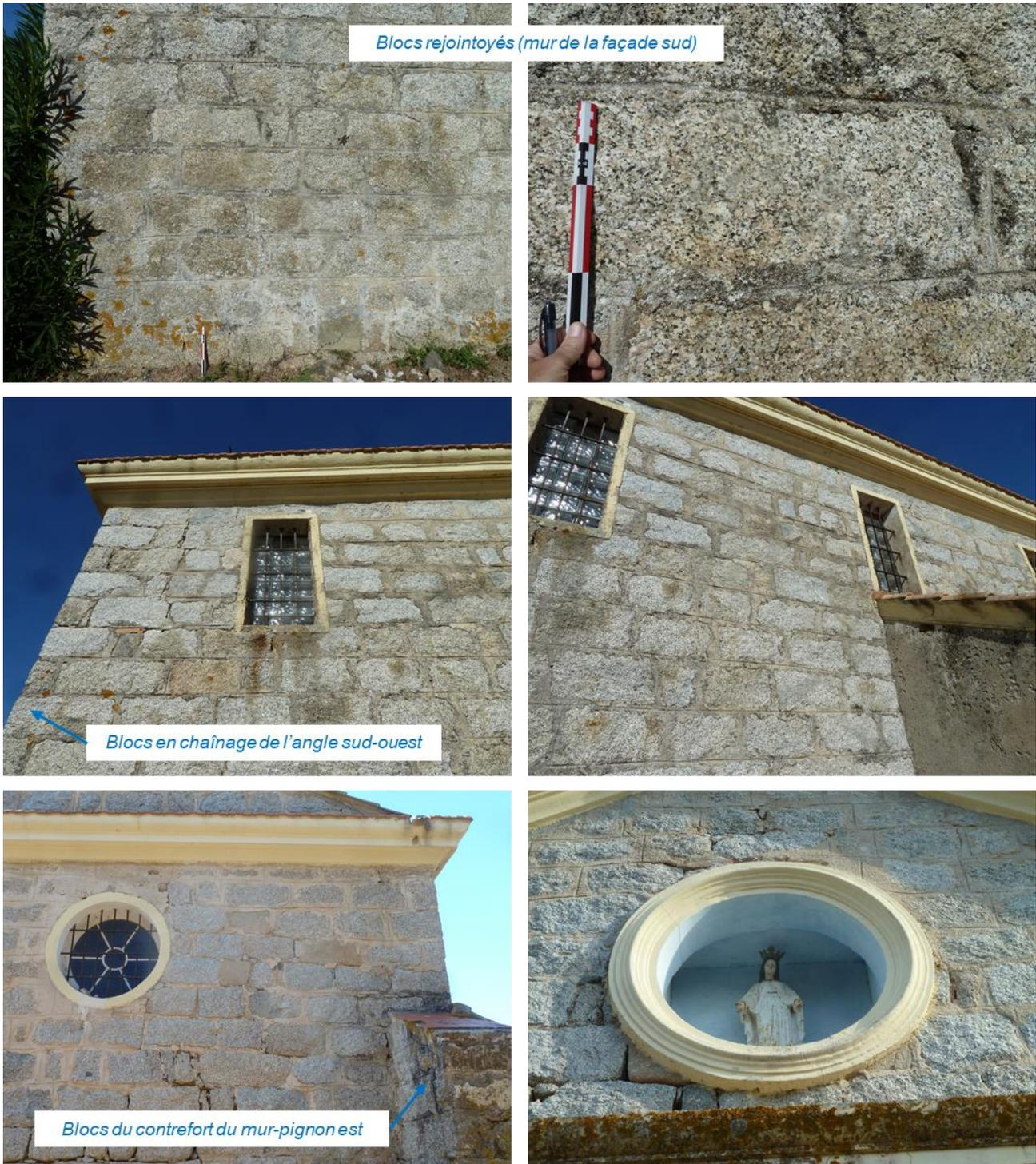
Figure 55 - Vues extérieures de la mise en œuvre du granite gris-clair-rosé à grain grossier sur la nef.
