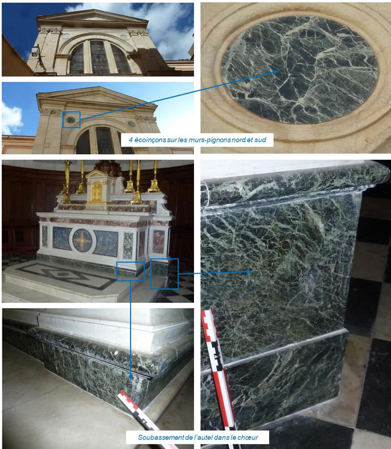
Figure 40 - Vues macroscopiques et de mise en œuvre du « Marbre vert de Bévinco » (supposé).
