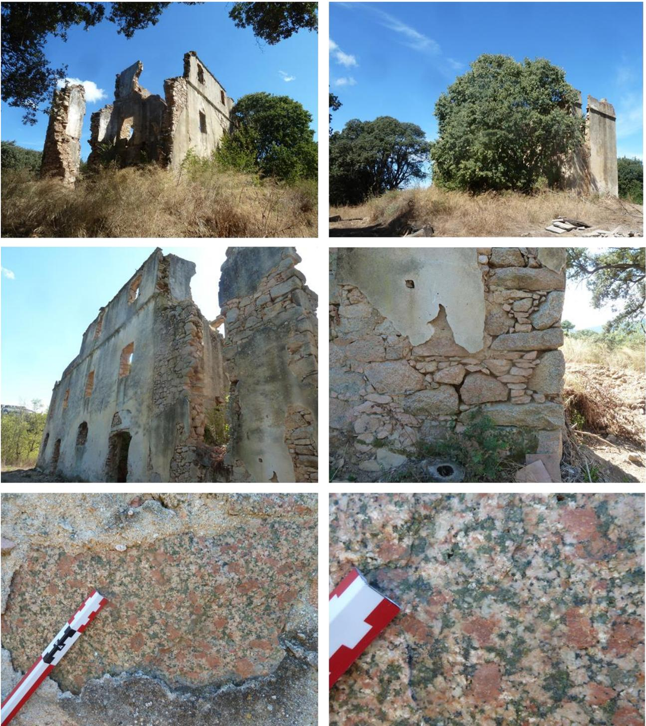
Figure 79 - Vues du château ruiné de Matoni illustrant la mise en œuvre de la Syénite de Matoni (Alata).
