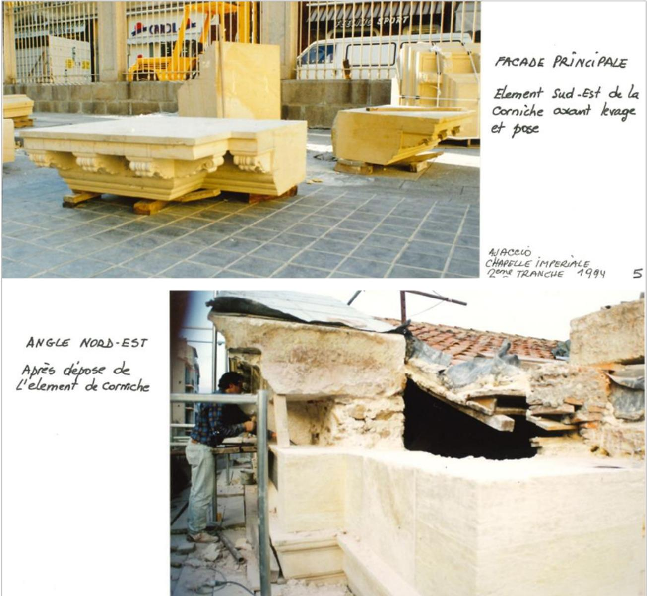
Figure 49 - Photos prises lors des travaux de restauration de la Chapelle Impériale de 1992-1994, témoignant de l'ampleur des travaux et du nombre important de blocs de Pierre de Saint-Florent remplacés (source : dossier DDOE à la DRAC de Corse).
