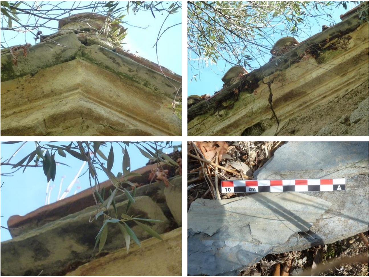
Figure 12 - Vue macroscopique d'un fragment et vues de mise en œuvre du schiste argileux gris-sombre, en pourtour de la couverture de la chapelle du tombeau Colonna d'Istria à Ajaccio.
