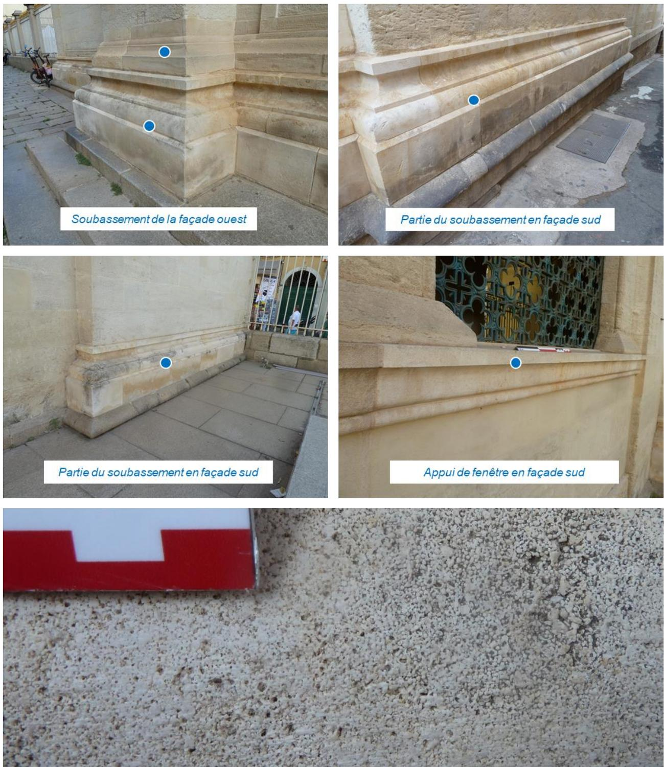
Figure 50 - Vues macroscopiques et de mise en œuvre de la Pierre de Chauvigny en restauration de la Chapelle Impériale.
