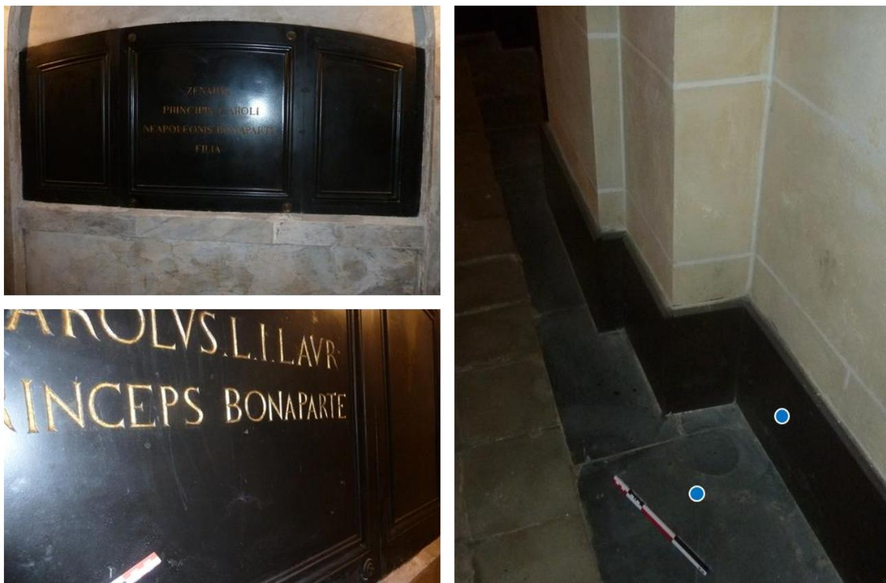
Figure 45 - Vues macroscopiques et de mise en œuvre du « Marbre noir » en sous-sol de la chapelle.
