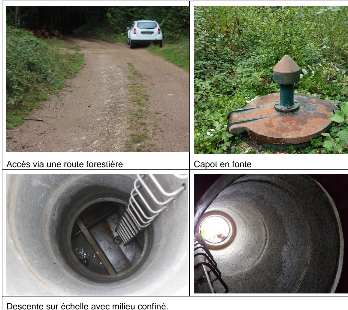
Illustration 10 : Echelle et accès à la chambre de captage vue d'en haut et d'en bas.
