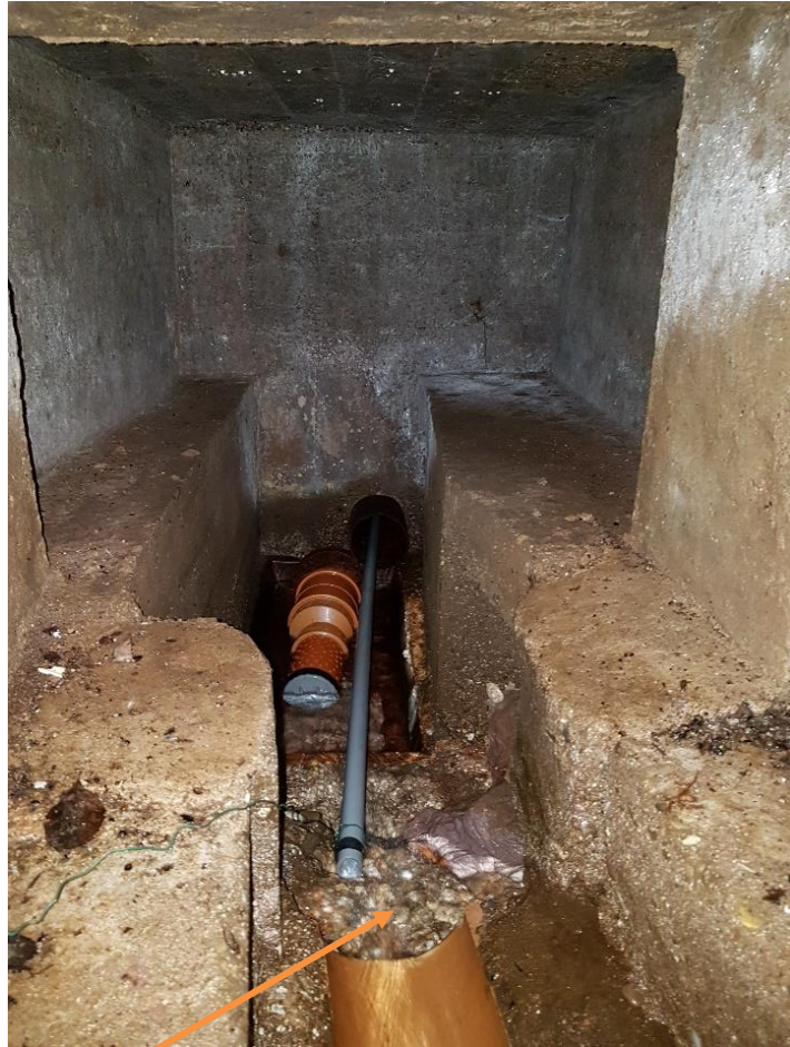
Illustration 15 : Vue de l'installation : une seule venue individuelle, captage du SDEA (avec filtre)
