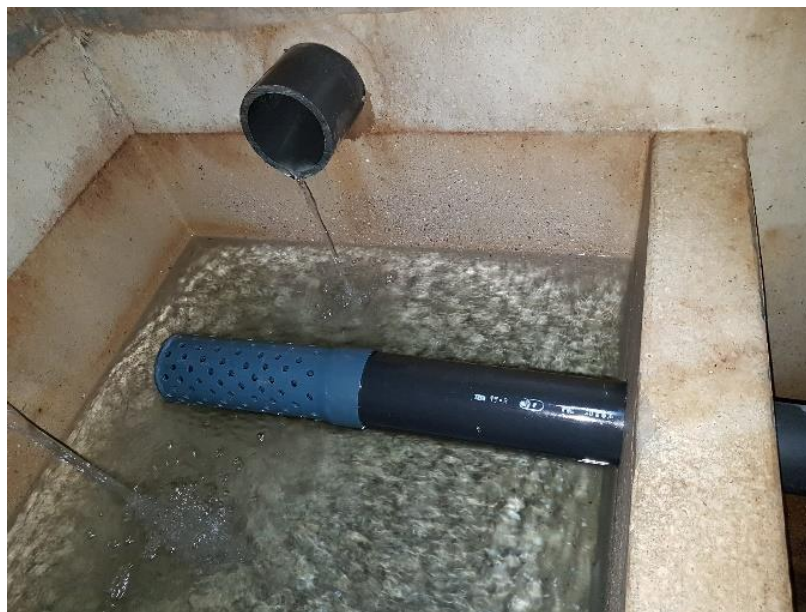
Illustration 11 : Vue de l'installation : venues des sources, captage du SDEA (avec filtre), évacuation du trop plein (03071X0096/AMT)
