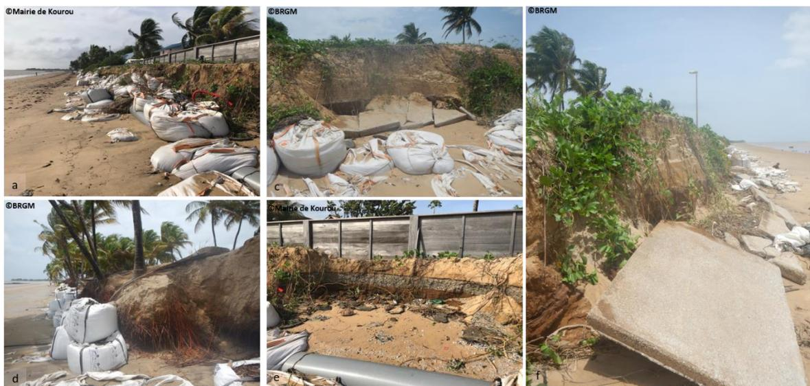
Figure 53 : Dégâts observés suite aux coups de mer d'avril 2020 le long de l'avenue de l'Anse (prise le 11 avril 2020) (Bossennec et Longueville, 2020).
