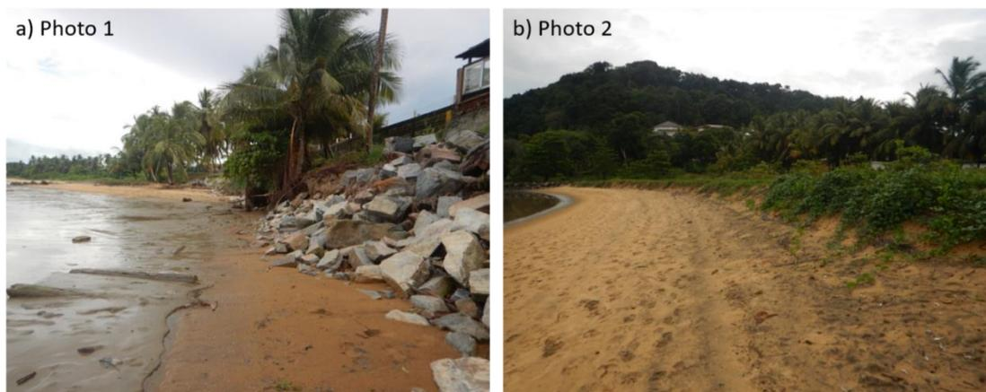
Figure 31 : (a) extrémité Nord : entretien des enrochements (b) extrémité Sud : talus d'érosion (photos novembre 2020).
