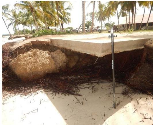
Figure 63 : Érosion sous une dalle de béton d'environ 90 cm novembre 2020.
