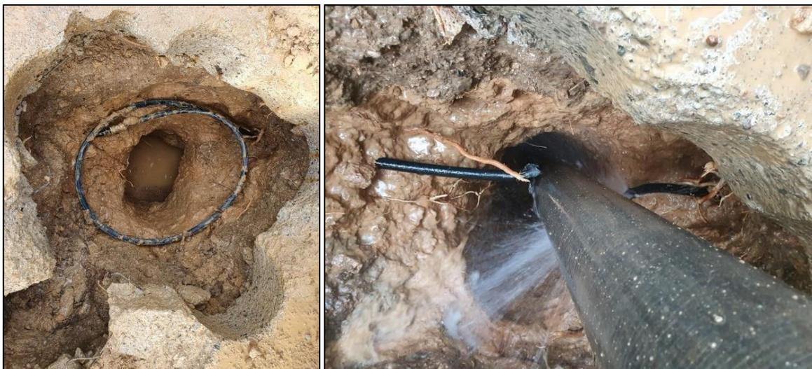
Figure A- 9 : Perforation d'un réseau lors de la foration du piézomètre superficiel (DEMT2)
