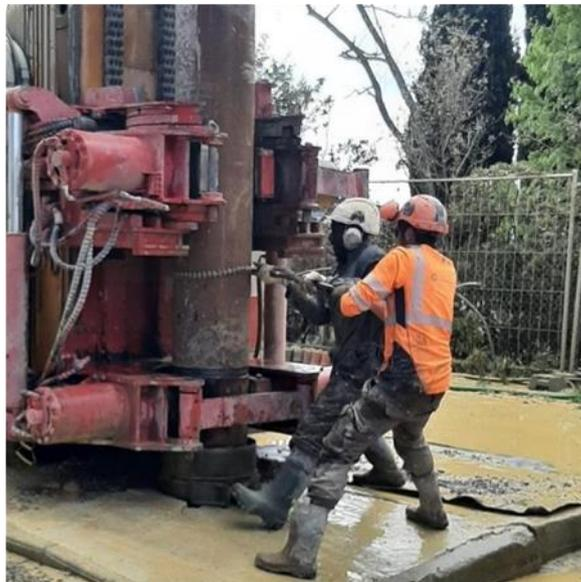
*Figure A- 22 : Déblocage des tubages à l'avancement*
