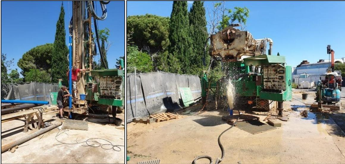
Figure A- 10 : Nettoyage du piézomètre superficiel
