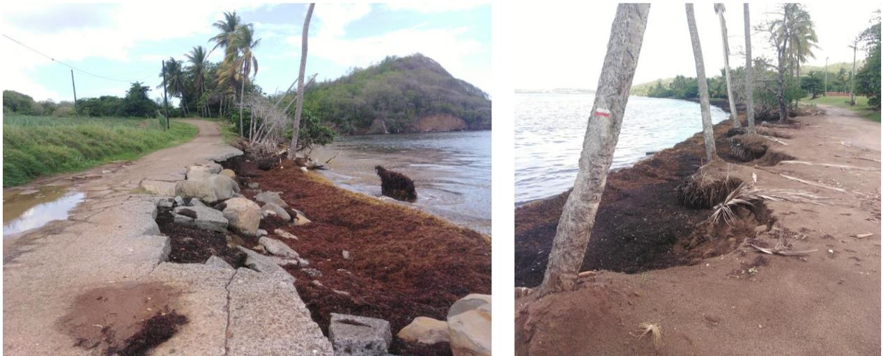
Illustration 23 : (à gauche) - Dans le secteur le plus au nord de la baie, la plage est très étroite et la route longeant la côte apparaît en mauvais état. (à droite) - Quelques dizaines de mètres plus au sud, l'arrière plage porte les marques d'une érosion chronique. Photographies capturées pendant la campagne de mesure en juillet 2020.
