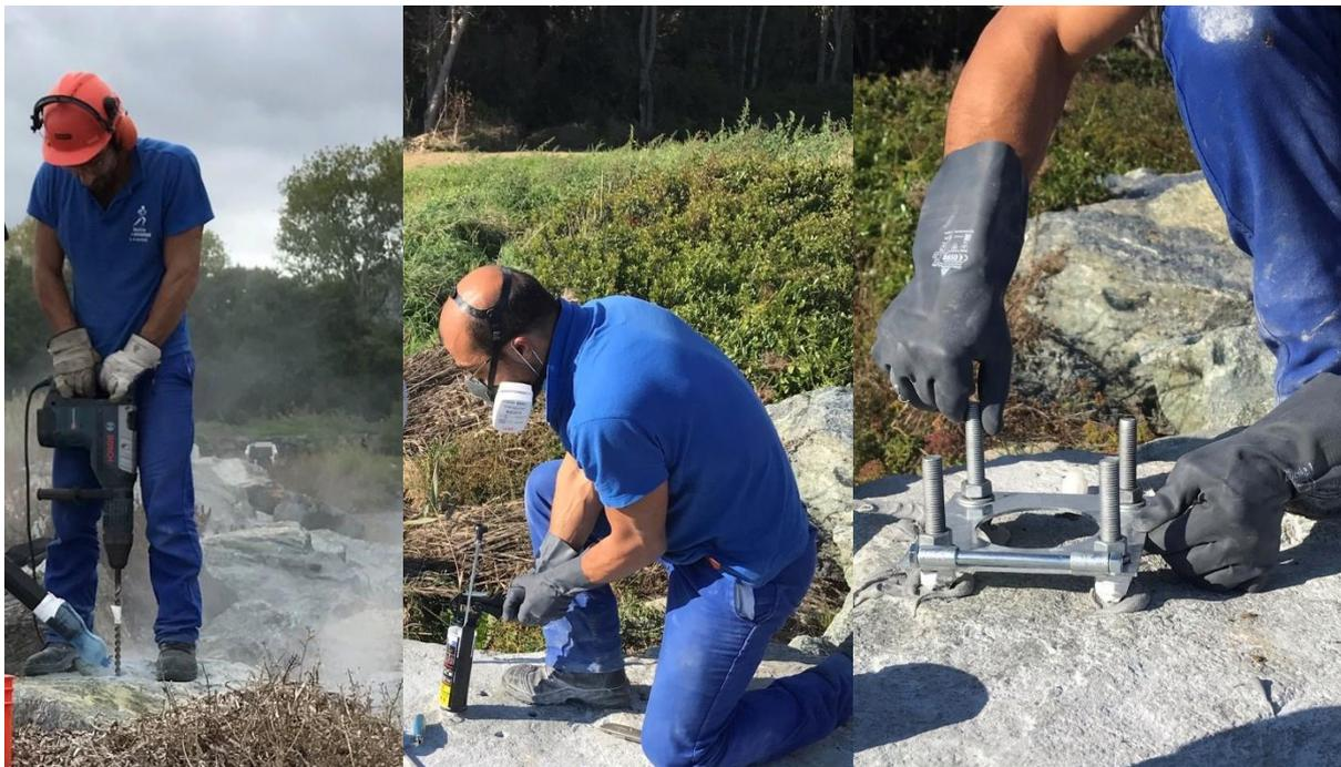
Figure 17 : Perforation de la roche (gauche), injection du scellement chimique (centre) et mise en place des tiges filetées (droite).
