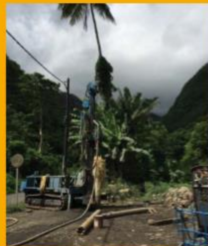
Fig. 5 : réalisation d'un forage à Paen
