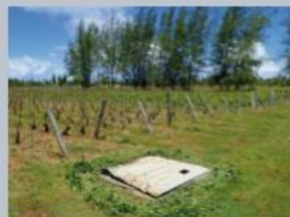
Puits situé au droit du motu de la Vigne à Rangiroa (PE-AF316)
