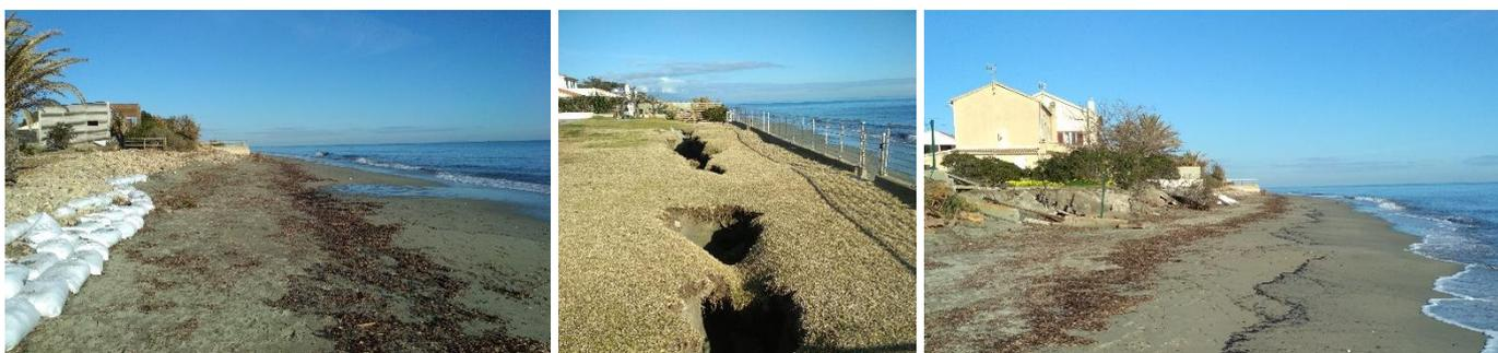
Figure 3 : Illustration des dégradations sur les infrastructures côtières de protection contre l'érosion marine (lotissement de Pineto à 2km environ au nord de l'embouchure , commune de Lucciana, février 2021).
