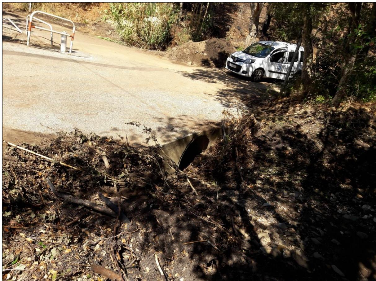
*Illustration 54 : Atterrissement de matériaux au niveau de l'ouvrage hydraulique. Photo fournie par les Services techniques de Bormes-lès-Mimosas.*
